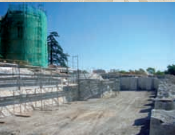
Arriba, a la derecha, plano del proyecto de reintegración del foso. Sobre estas líneas, vista de las obras en el lado sureste del foso
