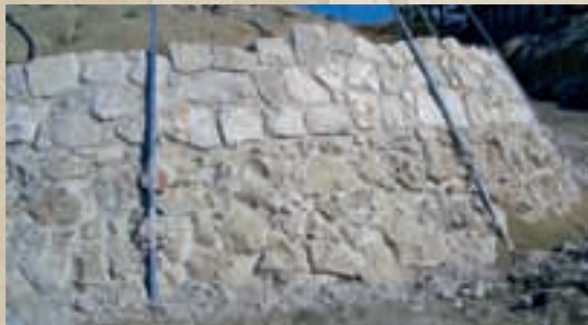
Contraste entre el aparejo original y el nuevo en la restitución de una de las torres de la barrera
