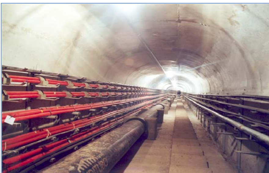
Disposición de redes de servicios en una galería.
