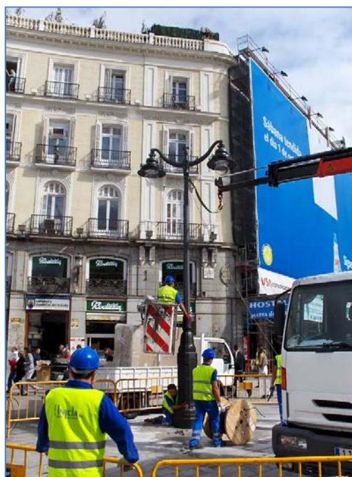
Instalación de farola.
