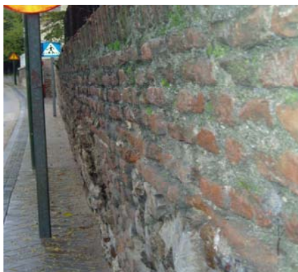
Tomando como referencia la verticalidad de la farola, se observa el acusado desplome del muro en este punto.
