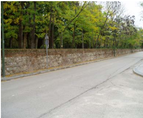
Vista general del tramo de cerramiento descrito
