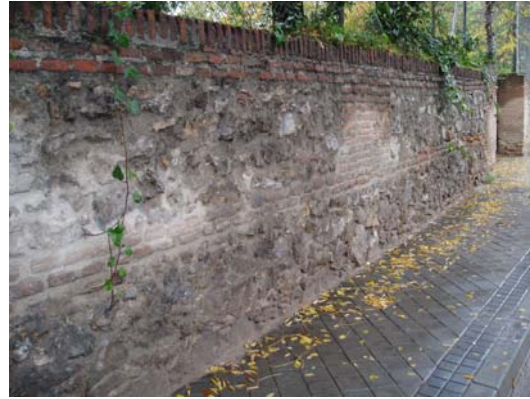
Vista general de la parte final de este tramo, hasta el primer acceso en Pº de la Alameda, en el que no se observan pérdidas graves, con un nivel de restauración básico a ejecutar.
