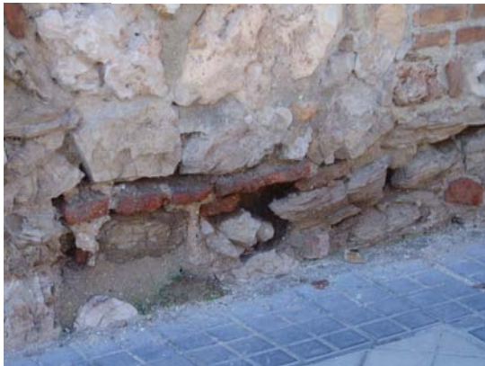
Alzado Sur, zócalo inferior con elementos desprendidos o deteriorados
