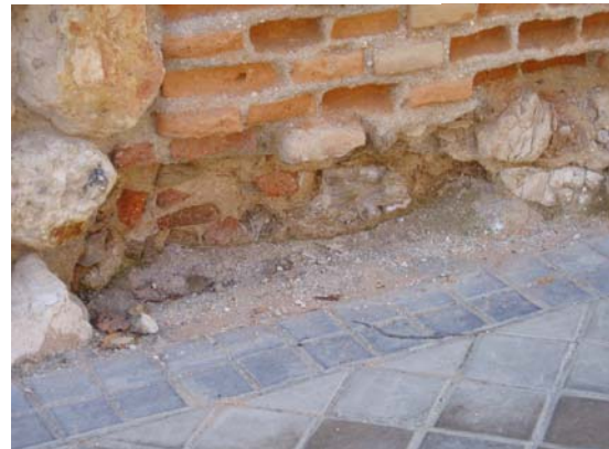
Alzado Sur, zócalo inferior con elementos desprendidos o deteriorados
