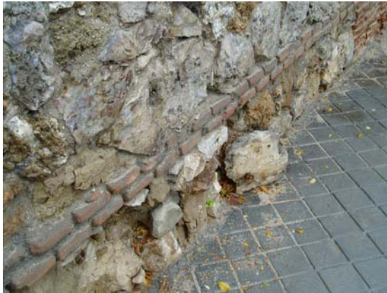
Alzado Sur, zócalo inferior con elementos desprendidos o deteriorados
