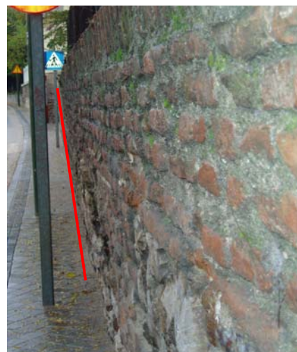
Se observa en ambas fotos el desplome existente en una parte del cerramiento, evidenciado con la verticalidad de las señales de tráfico
