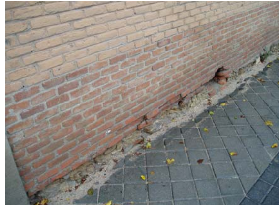
Alzado Sur, zócalo inferior con elementos desprendidos o deteriorados
