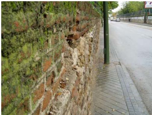
Tomando como referencia la verticalidad de la farola, se observa el acusado desplome del muro en este punto.
