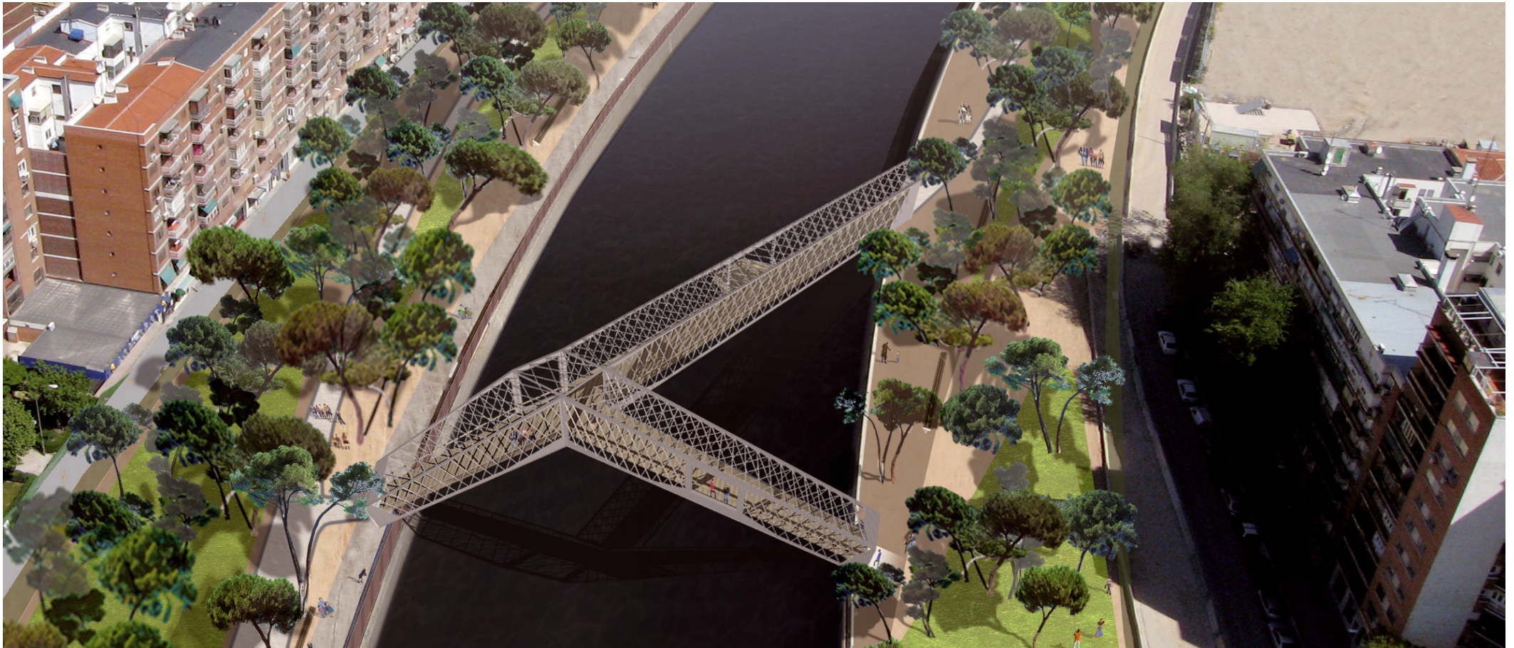
Pasarela de San Conrado (Y) S-5, 2010
