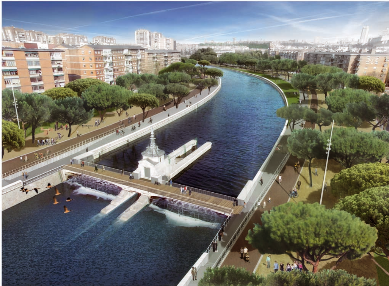
Pasarelas funcionales sobre presas. Modelo B. Sistema de Presas
