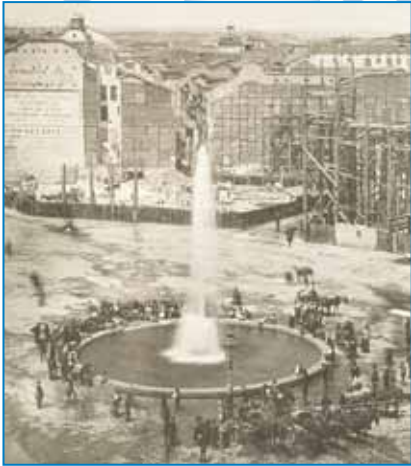
Obras de reforma de la Puerta del Sol en 1860 con el surtidor del Canal de Isabel II de 1858.
