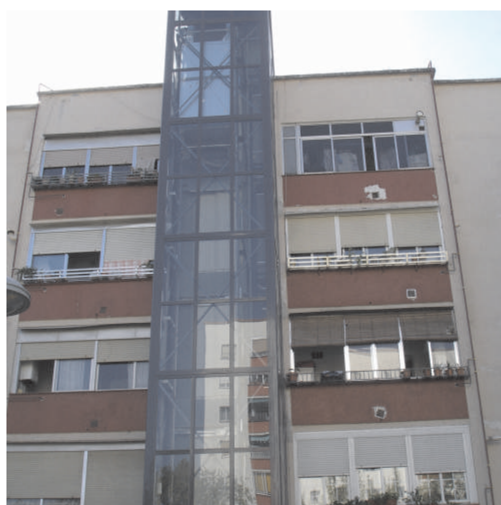
OBRAS DE INSTALACIÓN DE ASCENSOR Y DETALLE DE FACHADA POSTERIOR TERMINADA
