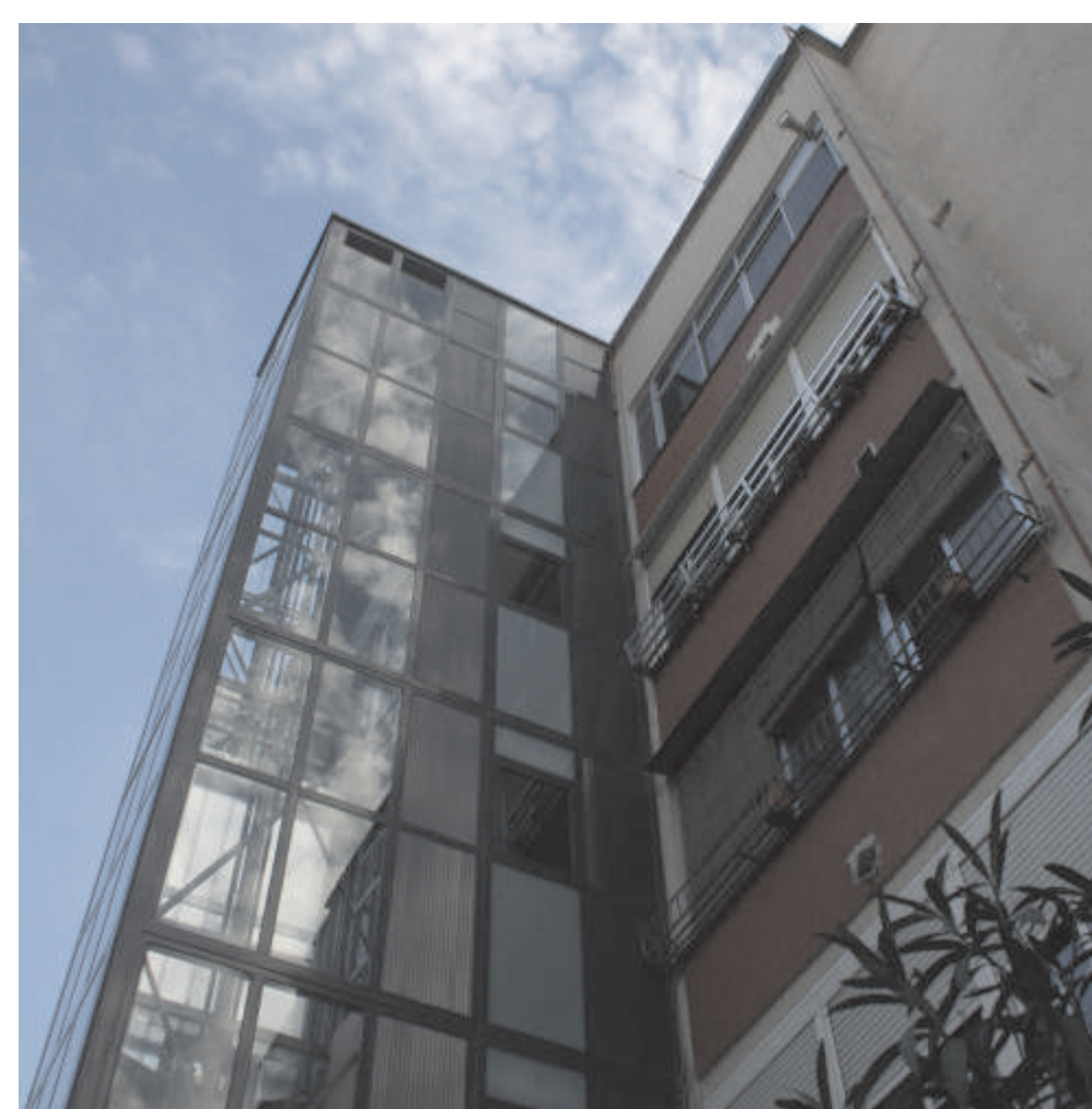
OBRAS DE INSTALACIÓN DE ASCENSOR Y DETALLE DE FACHADA POSTERIOR TERMINADA
