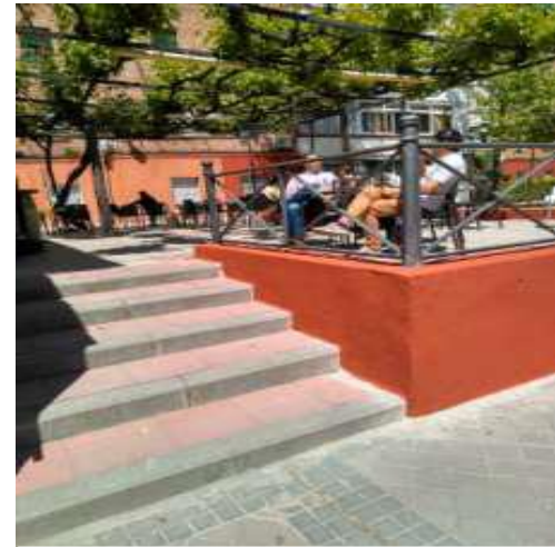
Arreglo de muro y escaleras en el Barrio de San Cristóbal
