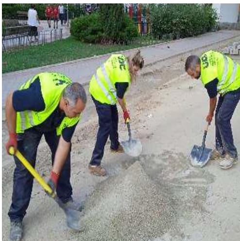
Construcción de bordillo en la Avda. de las Águilas
