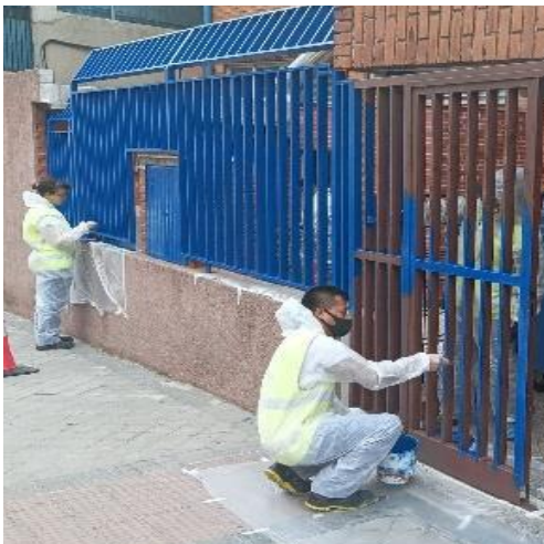
Pintura de vallas y acondicionamiento de muros en el CEIP Federico Rubio
