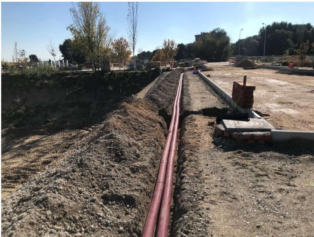
Dado que aún no se ha colocado la cinta plástica avisadora de alumbrado público, se recuerda al encargado de la contrata que debe colocarla según la Normalización de elementos constructivos:
