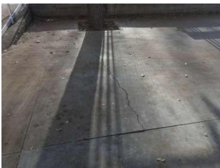
Pavimentos agrietados en patio [1]
