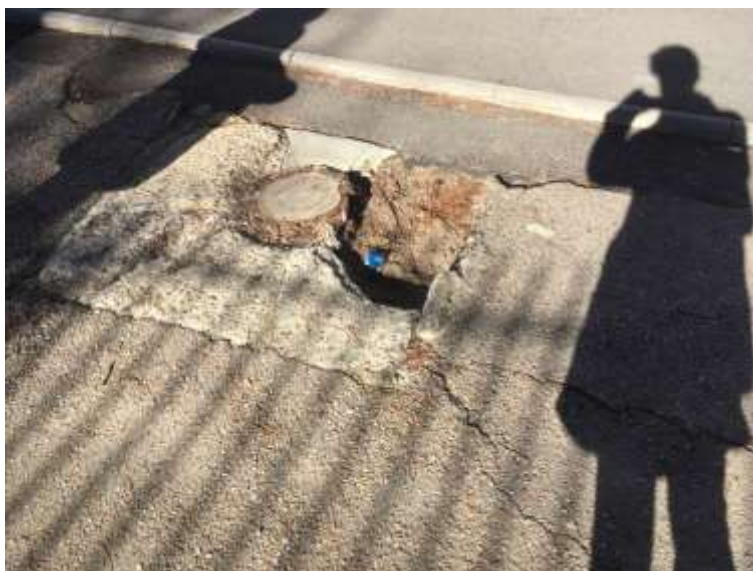
Desperfectos en solera asfáltica por acción del arbolado y la humedad
