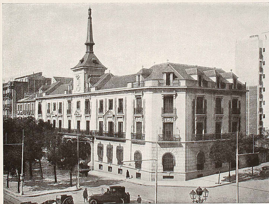
Edificio municipal del Distrito de la Universidad (En él se encuentra la Casa de Socorro)
