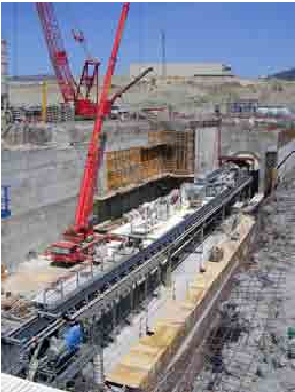
FOTO 11. Tuneladora Colector By-Pass Abroñigales
