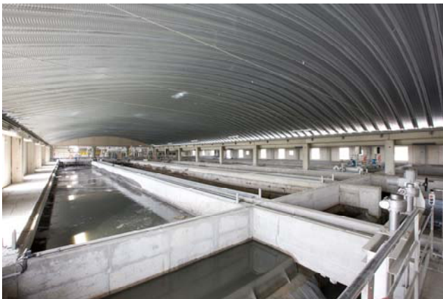
Foto 8. Canales de decantación
