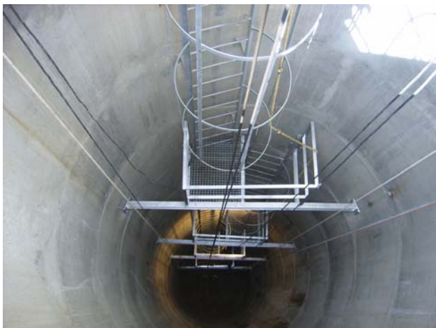
Foto 18. Colocación tramos escaleras.
