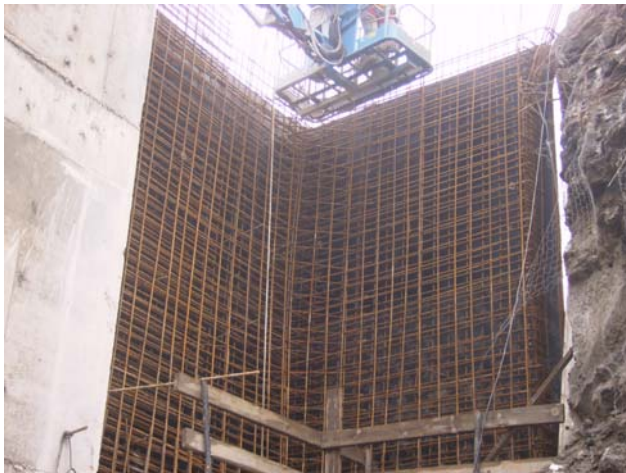
Foto 16. Ejecución muro contención tierras Foto 17. Relleno compactación talud
