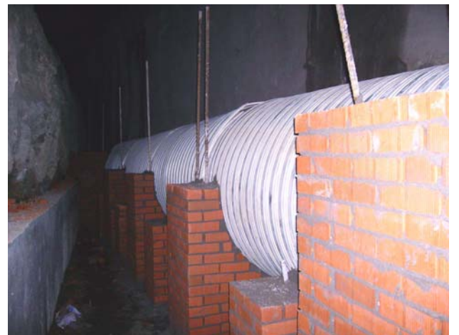
Foto 19. Desvío provisional conex. Colector B.
