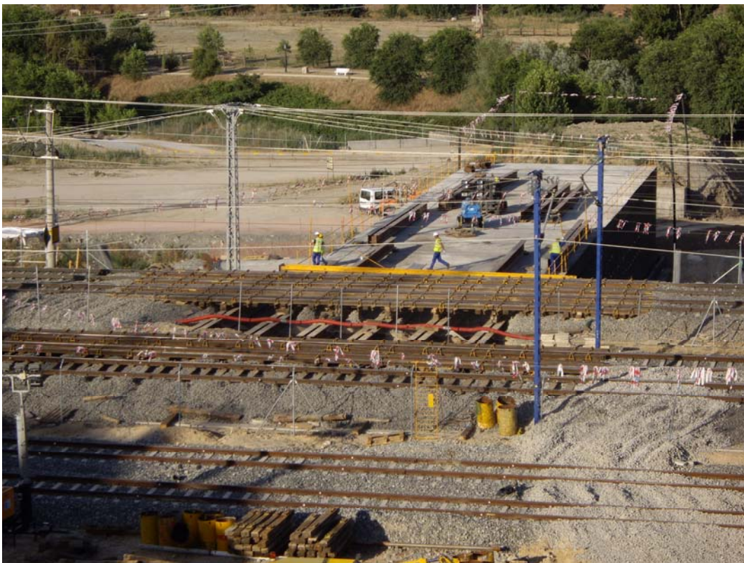
Foto 20. Apeo de las vías del AVE y empuje del cajón hincado.
