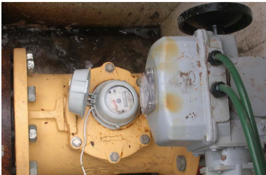
Foto 24. Medidor consumo agua regenerada
