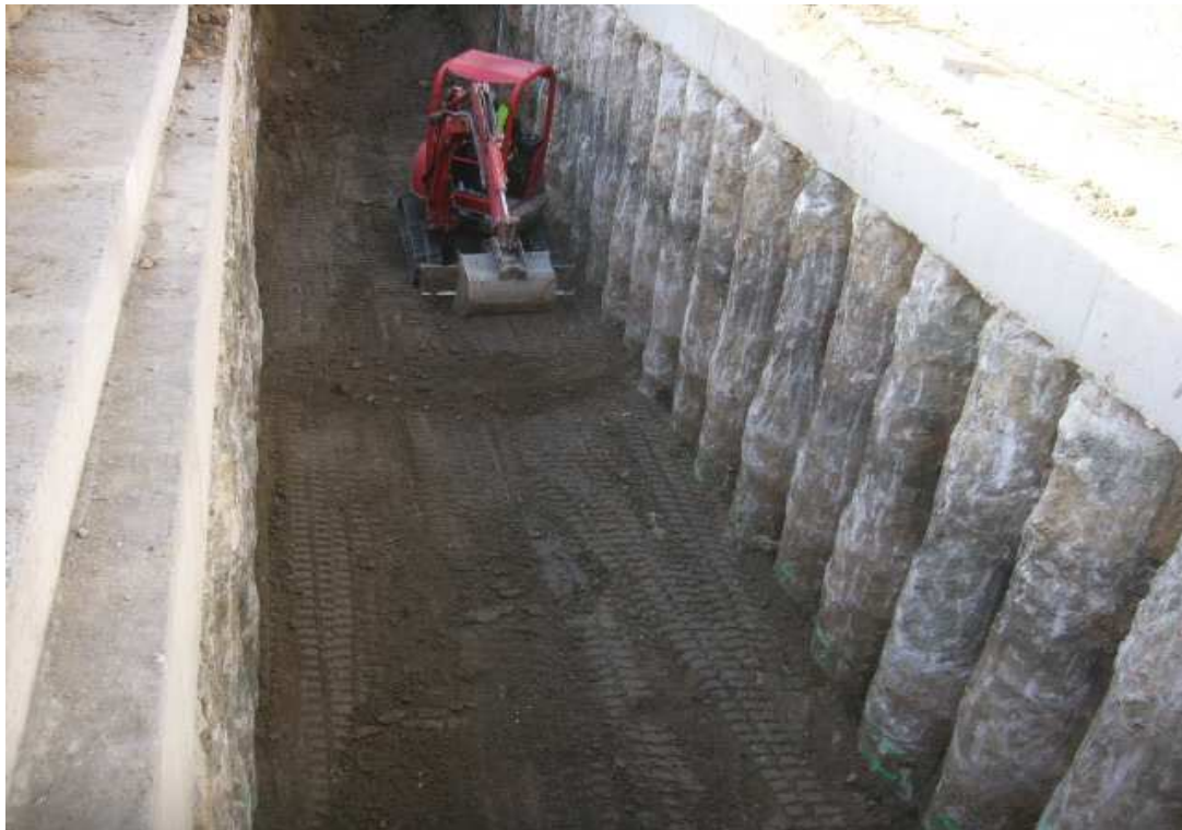
Foto33. Excavación entre pantallas
