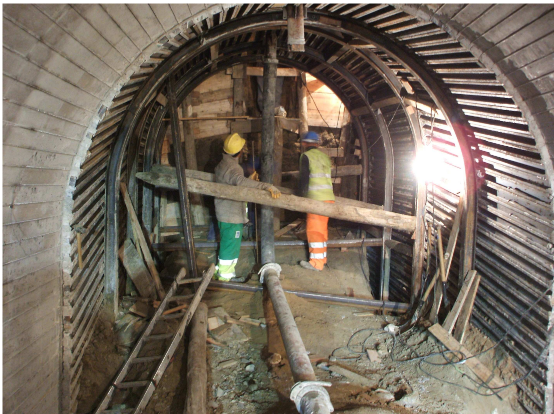
Foto 31 . Ejecución de mina calle Barrilero.
