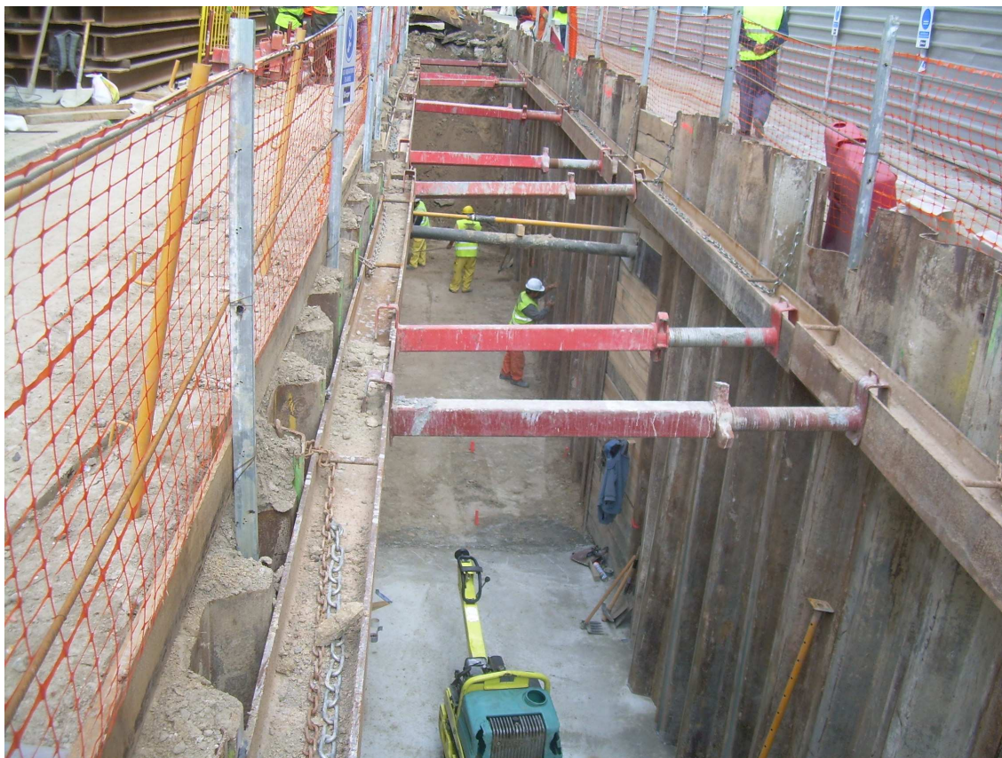
Foto 25. Ejecución del colector a cielo abierto excavado entre tablestacas.
