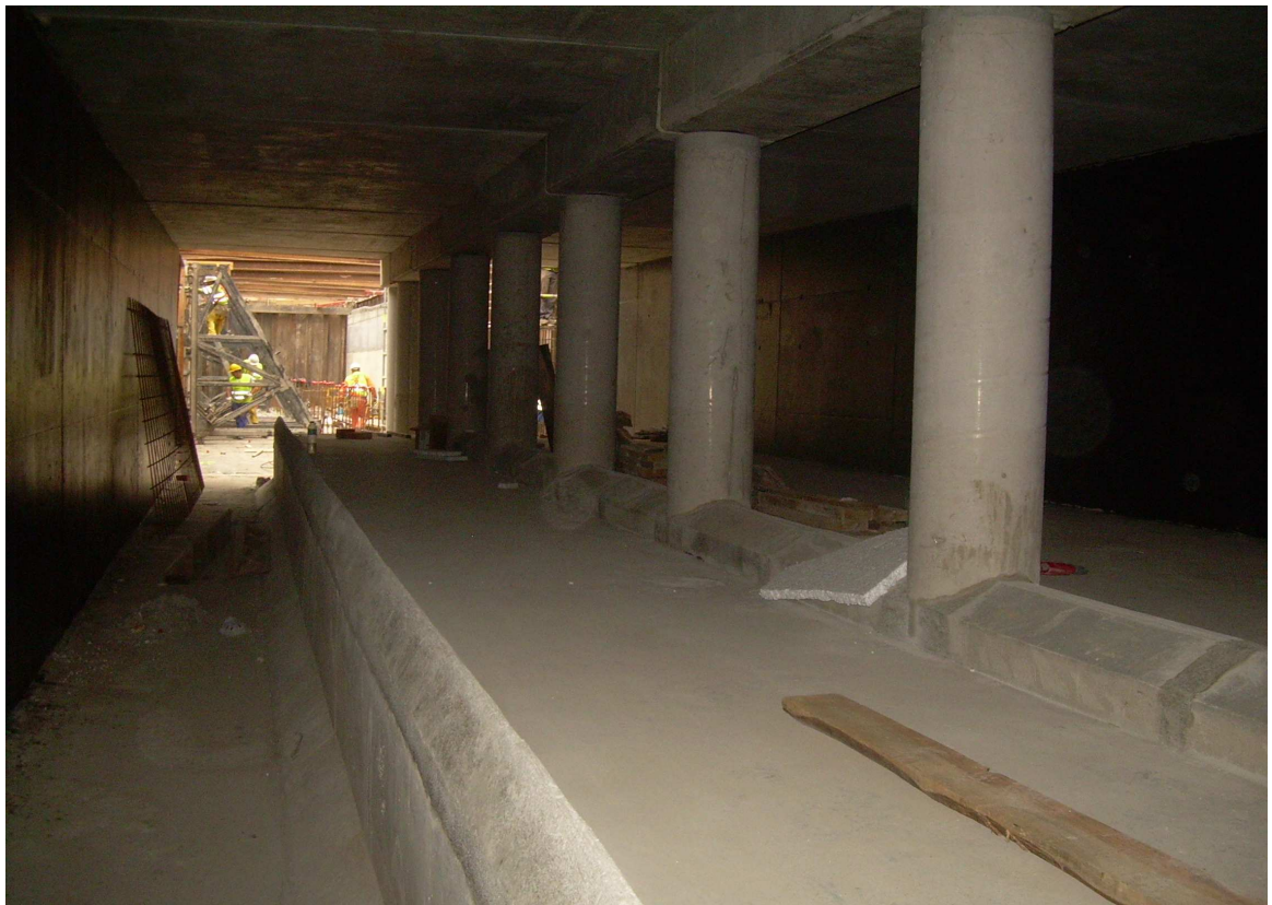
Foto 24. Ejecución del estanque de tormentas.
