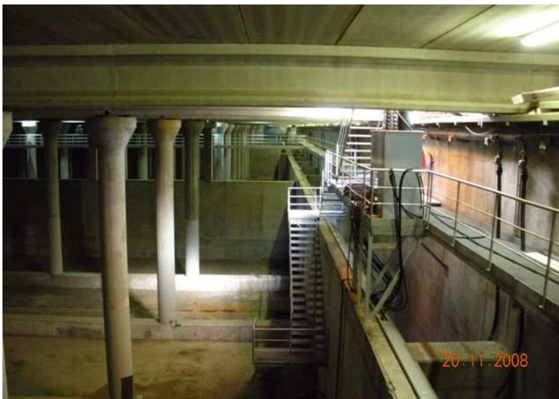
Foto 22. Interior del estanque. Pasarela perimetral.
