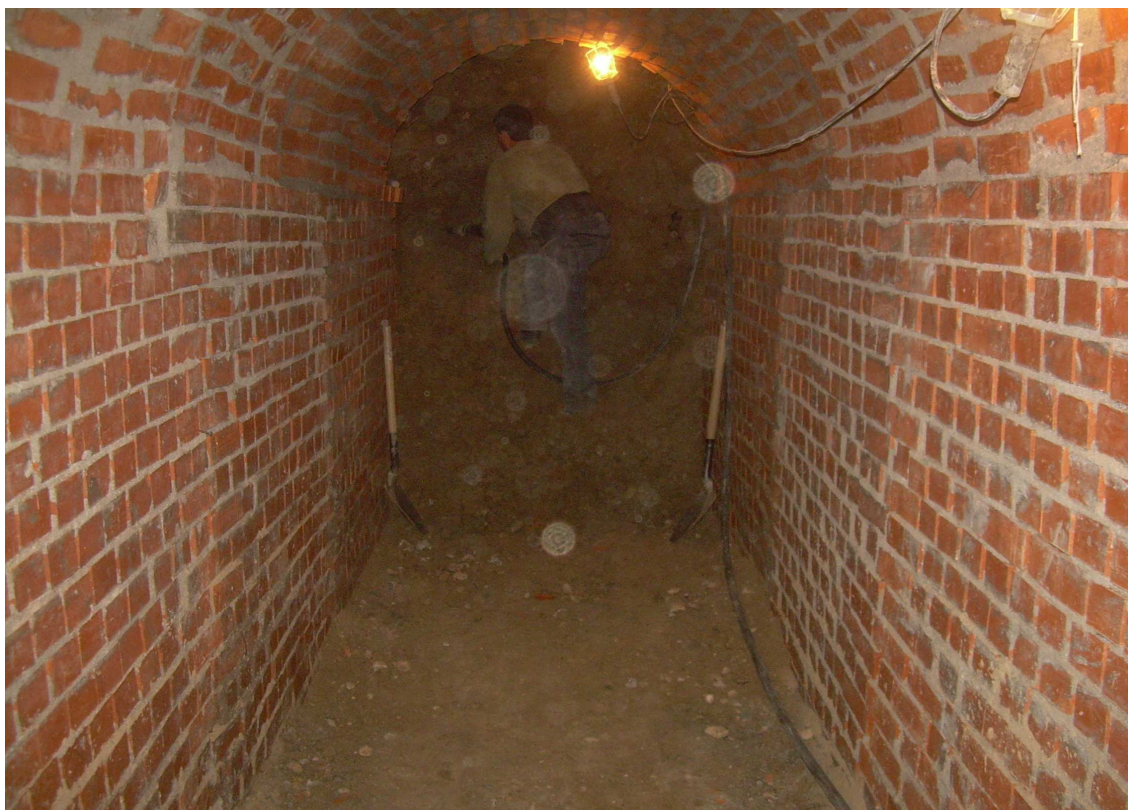
Foto 26 . Ejecución de tramo de colector excavado en mina.
