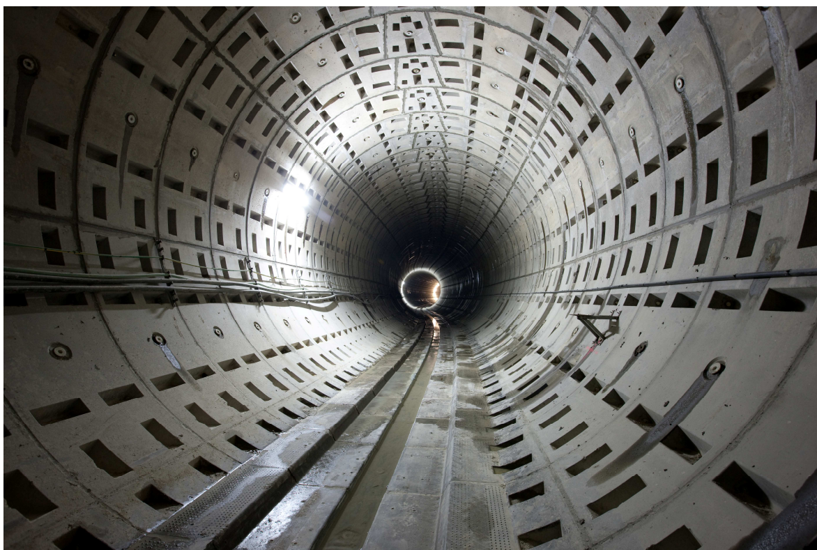
Foto 19. Nuevo colector de Arroyofresno
