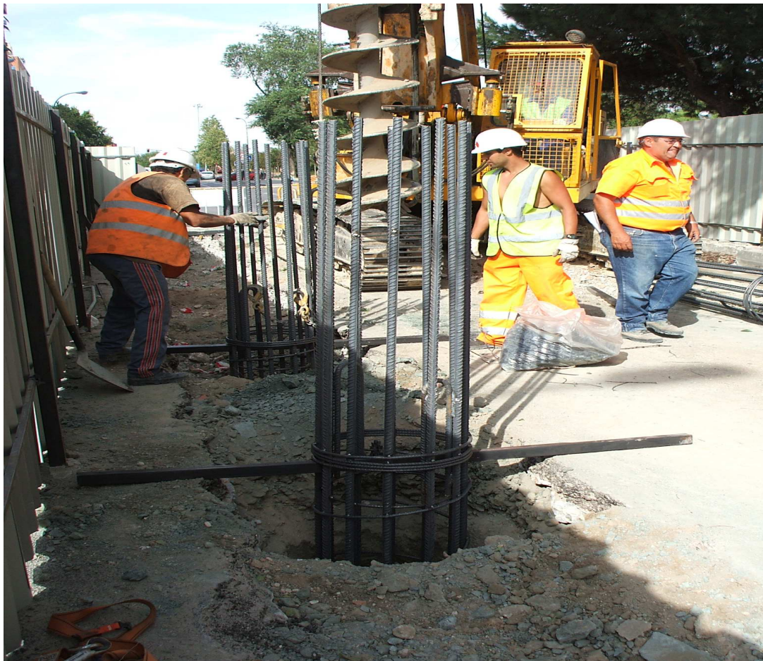
Foto 30. Ejecución de pilotes.
