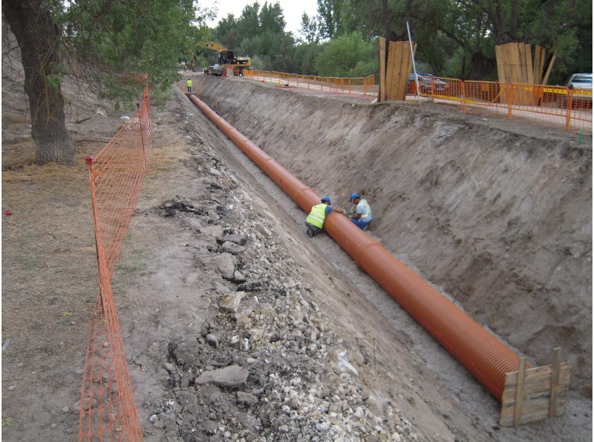
Foto 35. Montaje de tubería de 600mm
