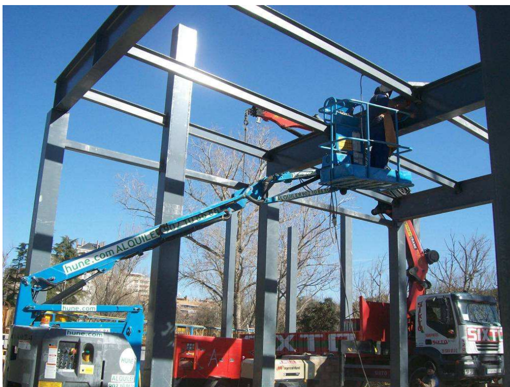
Foto 37. Montaje de estructura del edificio
