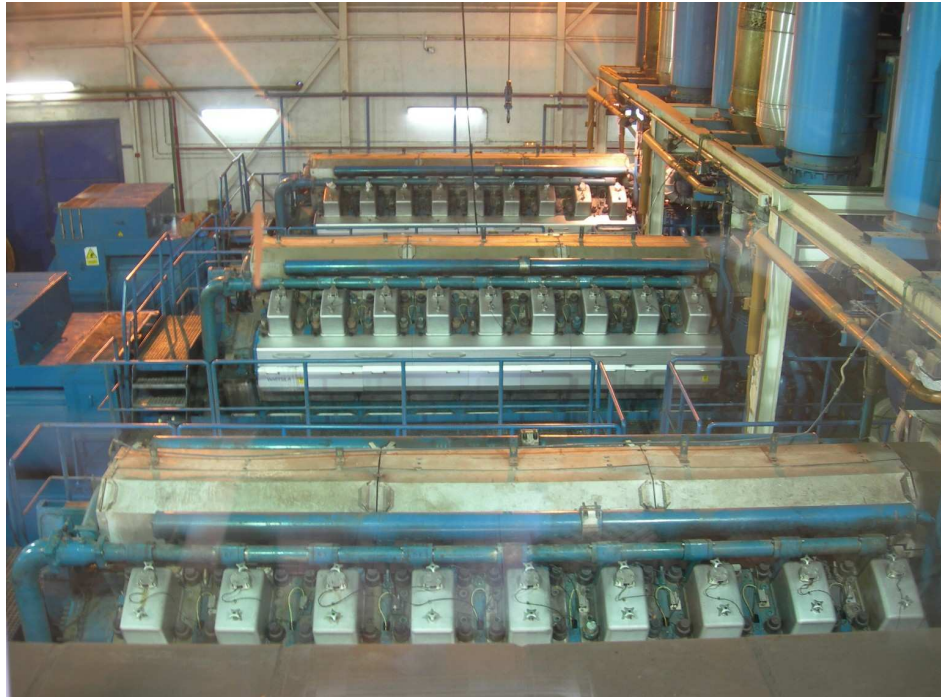
Foto 15. Motores de cogeneración del secado de Butarque
