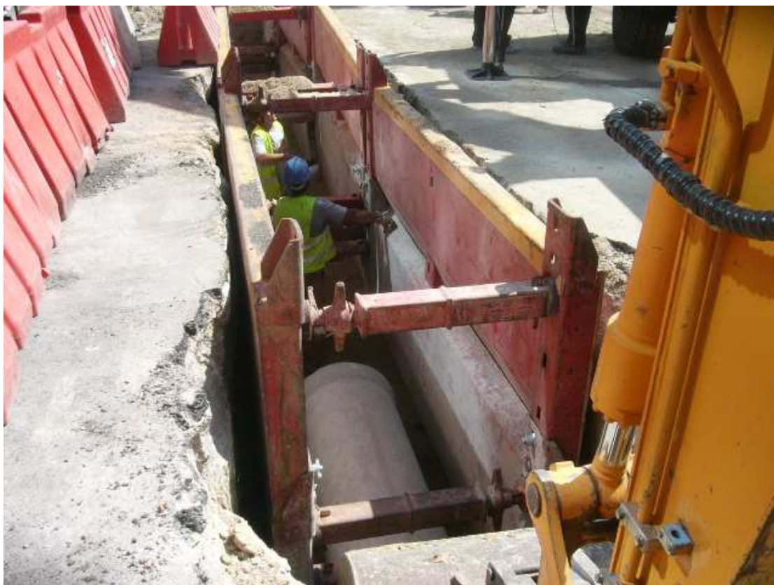
Foto 34. Desvío del colector existente
