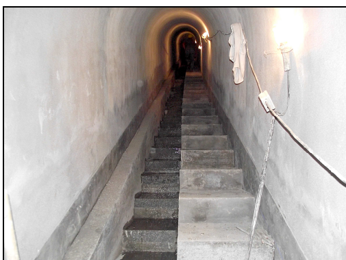
Tramo de galería con 40% de pendiente
