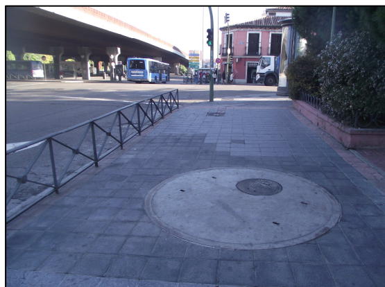
Detalle tapa desmontable en PR-2
