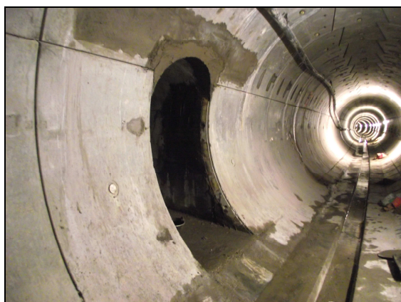
Entronque Túnel-Galería Conexión con PR
