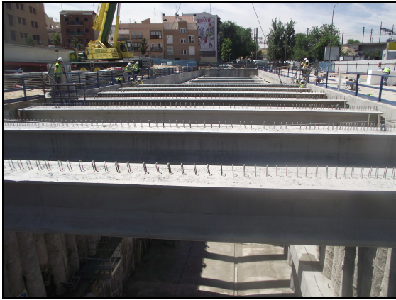
Colocación de vigas en la cubierta del Pozo de Ataque
