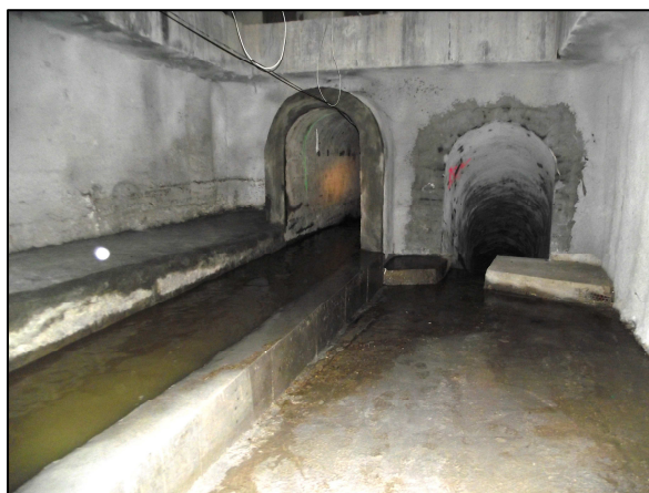
Vista aliviadero en colector existente e inicio nuevo colector
