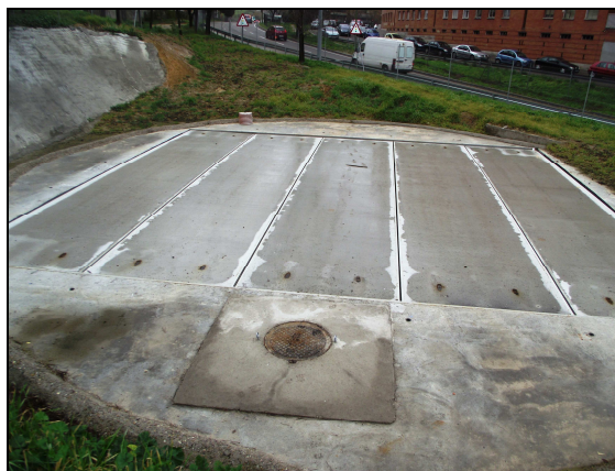
Vista losa de cubierta: acceso de material y personal para mantenimiento.
