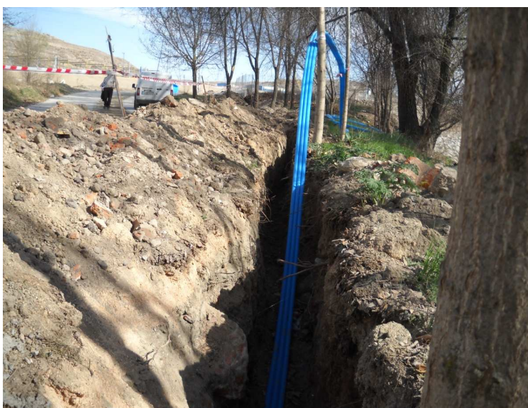
Acometida de tritubo en entorno de Abroñigal
