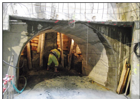
Ejecución mina de conexión con Túnel Doblado Colector B
