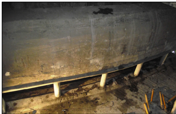
Ventanas-Aliviadero en el colector B existente finalizadas
