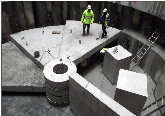
Colocación escalones prefabricados 1ª vuelta sobre dados de hormigón
