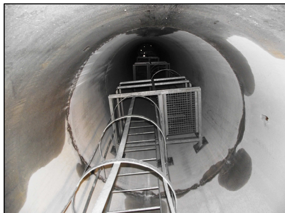
Escalera de acero galvanizado Pozos de hormigón
