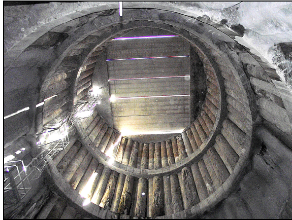
Vista de la losa de cubierta (placas Pandal) desde el interior del pozo
