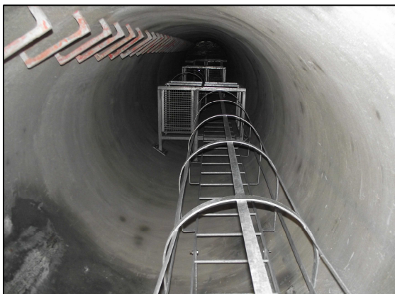
Escalera de acero galvanizado Pozos de ladrillo
