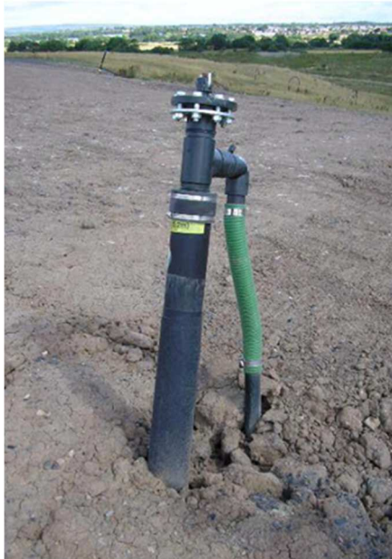
Figura 84. Ejemplo pozo de extracción de biogás (SRL Consulting).
