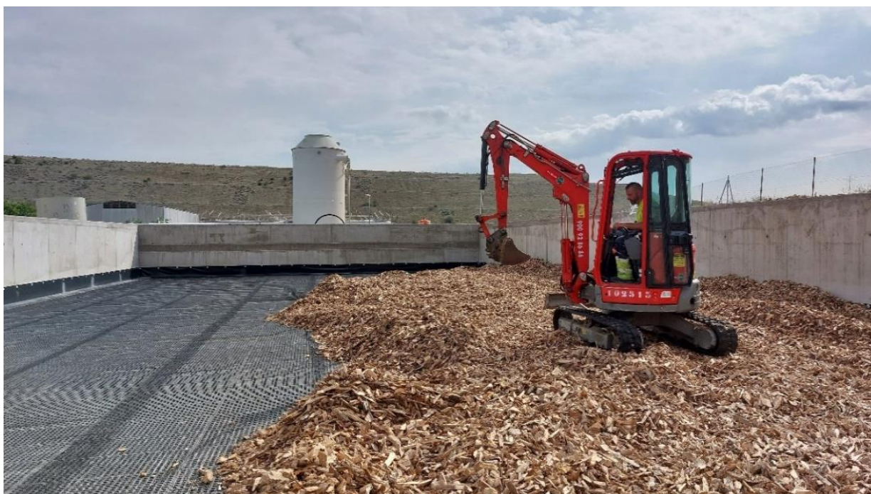
Colocación del biomedio orgánico en el biofiltro de nueva construcción
