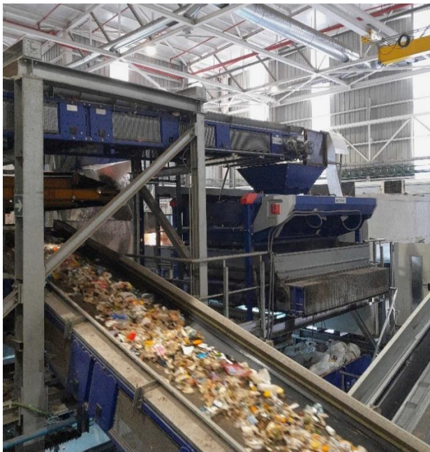
Planta de tratamiento mecánico del centro de clasificación y valorización energética “Las Lomas”
