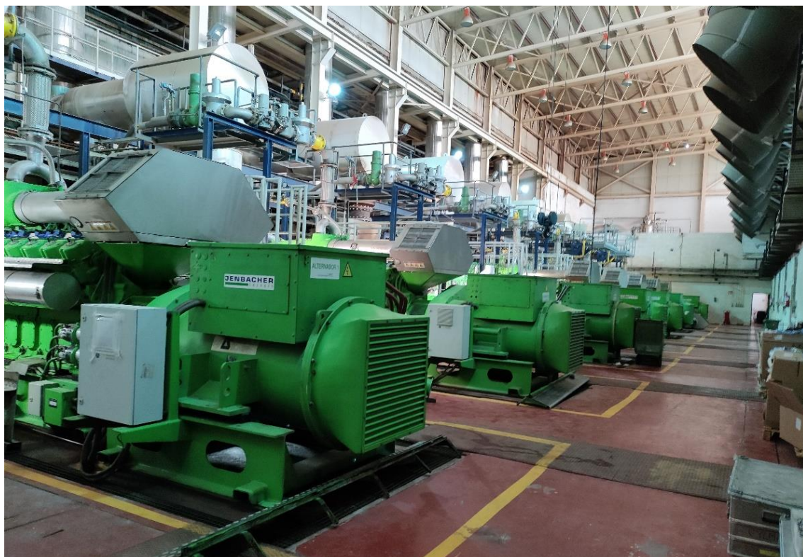
Motogeneradores del centro de desgasificación y generación eléctrica “La Galiana”
