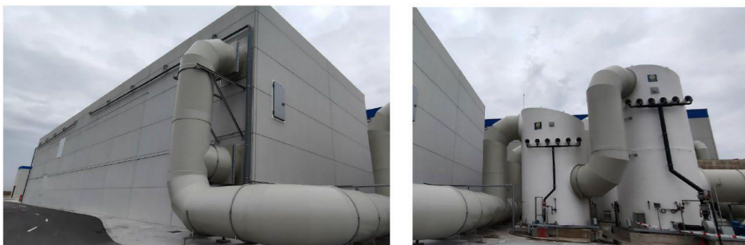
Biofiltro de la planta de tratamiento de materia orgánica “Los Cantiles”
