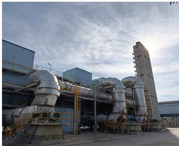
Chimeneas del centro de clasificación y valorización energética "Las Lomas" (una por cada línea)
