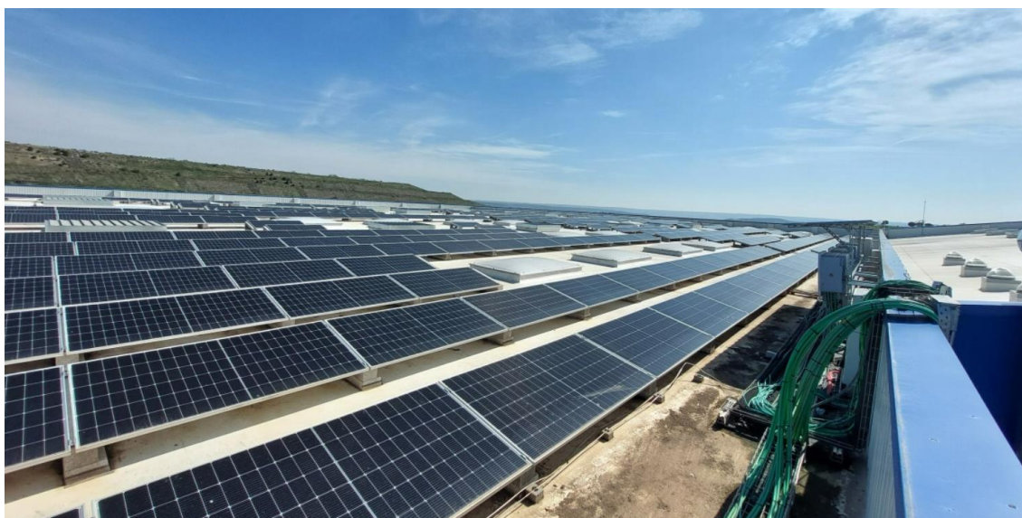
Instalación de placas fotovoltaicas en "Los Cantiles"
