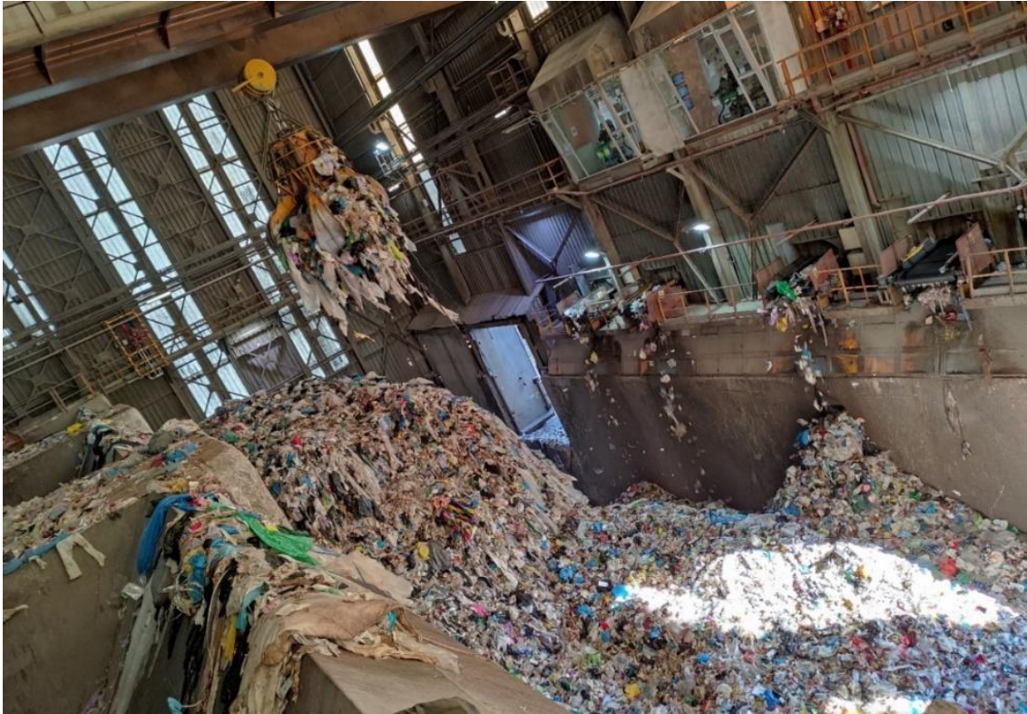
Foso de CDR donde se almacenan los rechazos que se someten a valorización energética en el centro de clasificación y valorización energética "Las Lomas"
