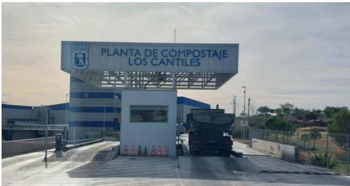
Báscula del centro de tratamiento de Los Cantiles
