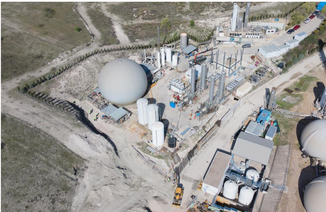
Ampliación de la planta de tratamiento de biogás (PTB)
