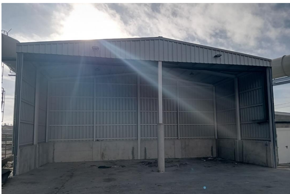
Nueva nave de caracterizaciones en plataforma descarga de las Dehesas
