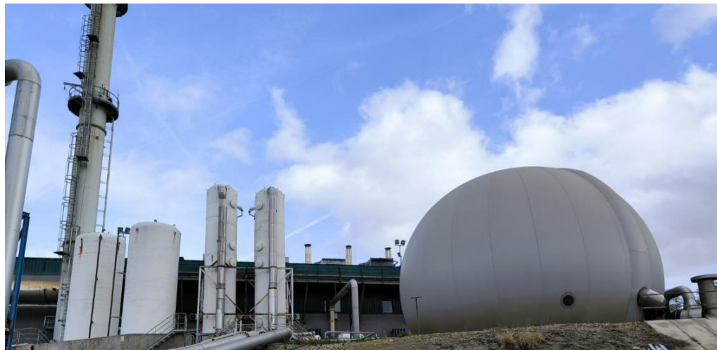
Tratamiento de biogás en el centro de desgasificación y generación eléctrica "La Galiana"
