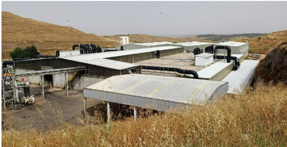
Nave de compostaje y biofiltros
