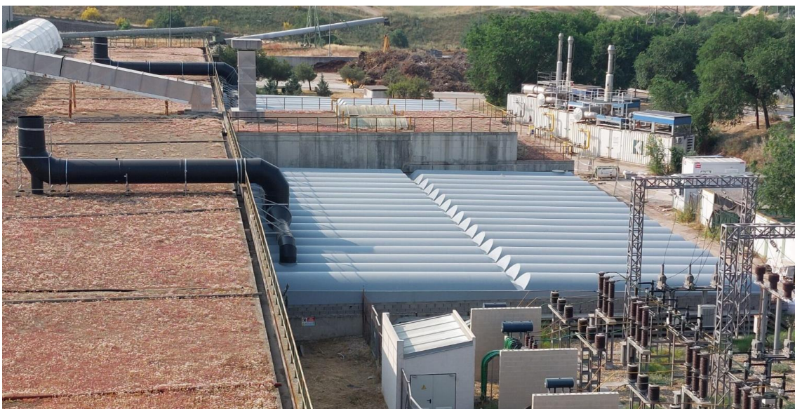
Reacondicionamiento y cubrición de biofiltros de compostaje
