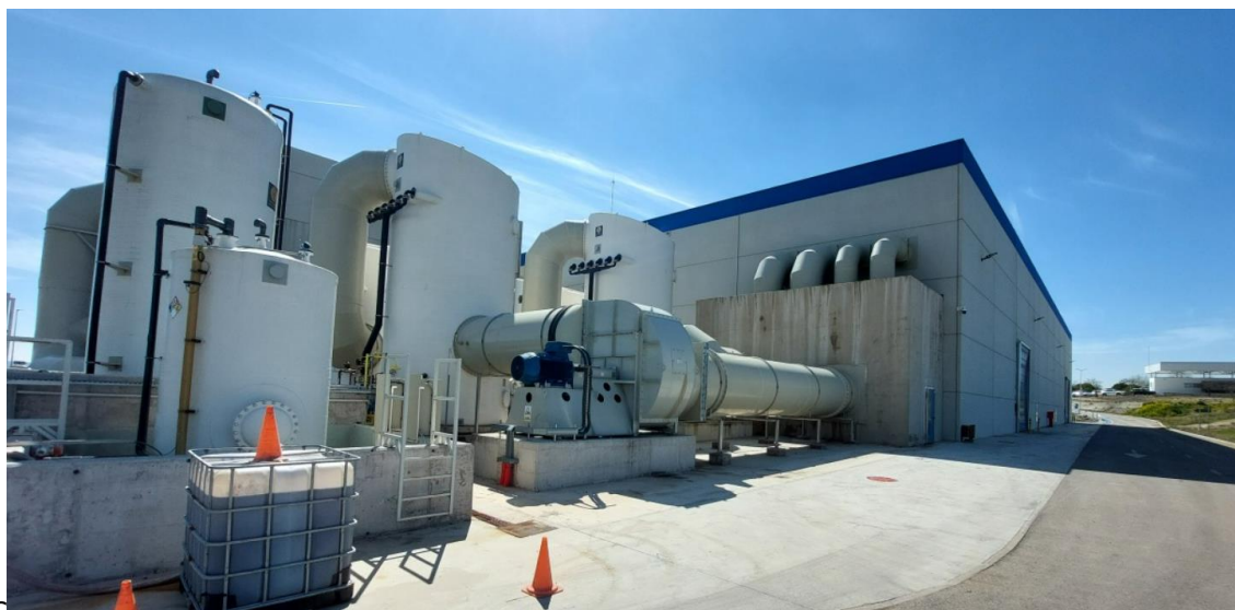
Biofiltro de la planta de tratamiento de materia orgánica "Los Cantiles"
