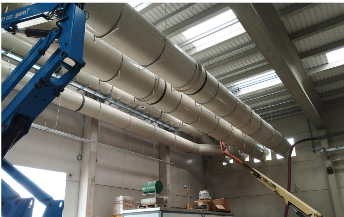
Montaje del sistema de desodorización.
