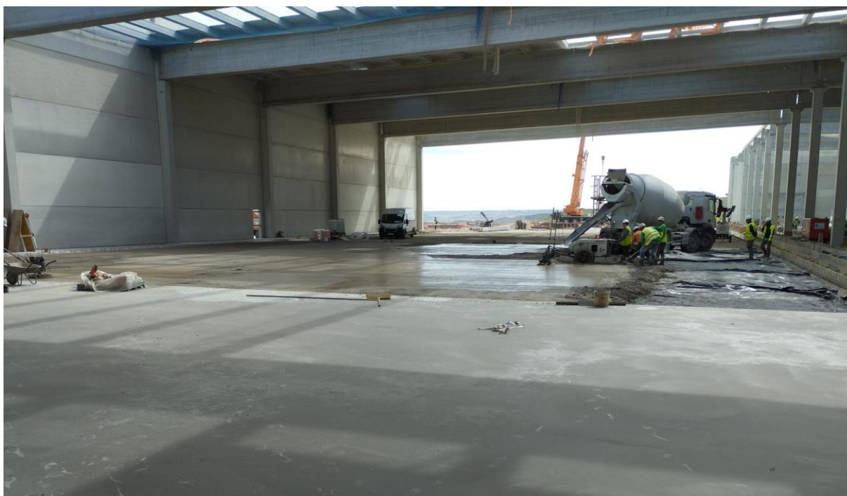
Ejecución de soleras.
