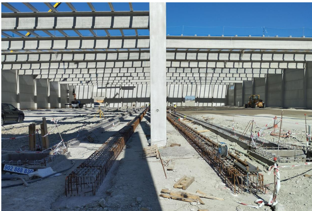
Montaje de la cubierta de tratamiento biológico
