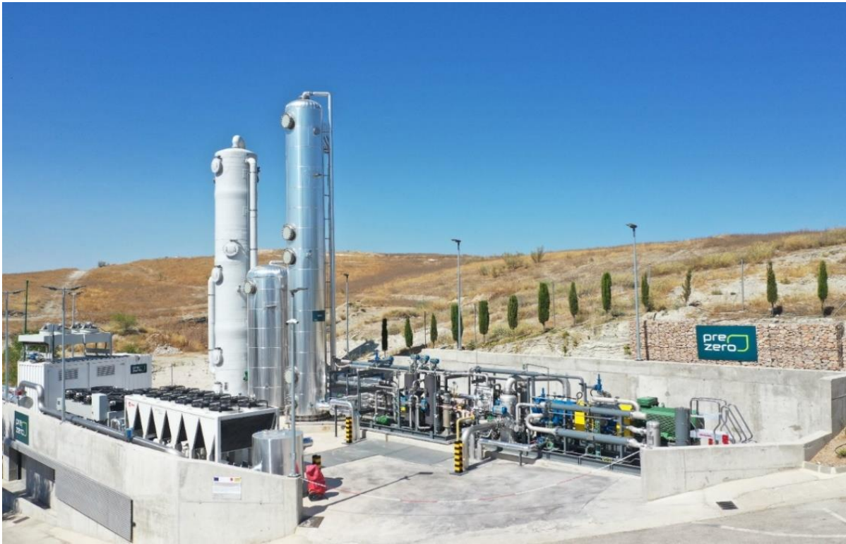
Nueva línea de lavado o upgrading de la PTB
