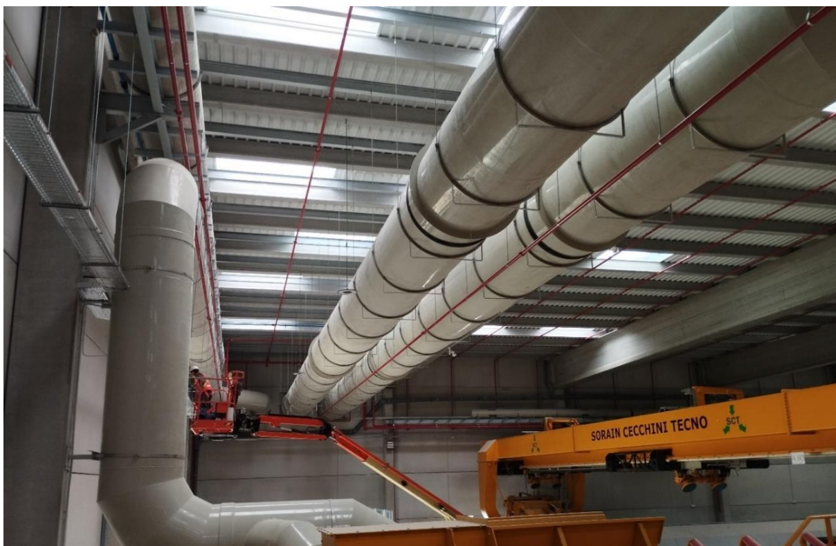
Desodorización y aire comprimido
