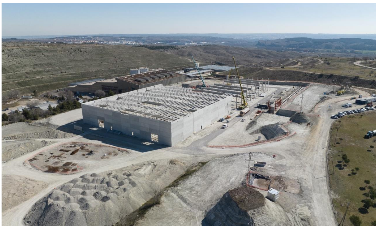
Montaje de la estructura prefabricada
