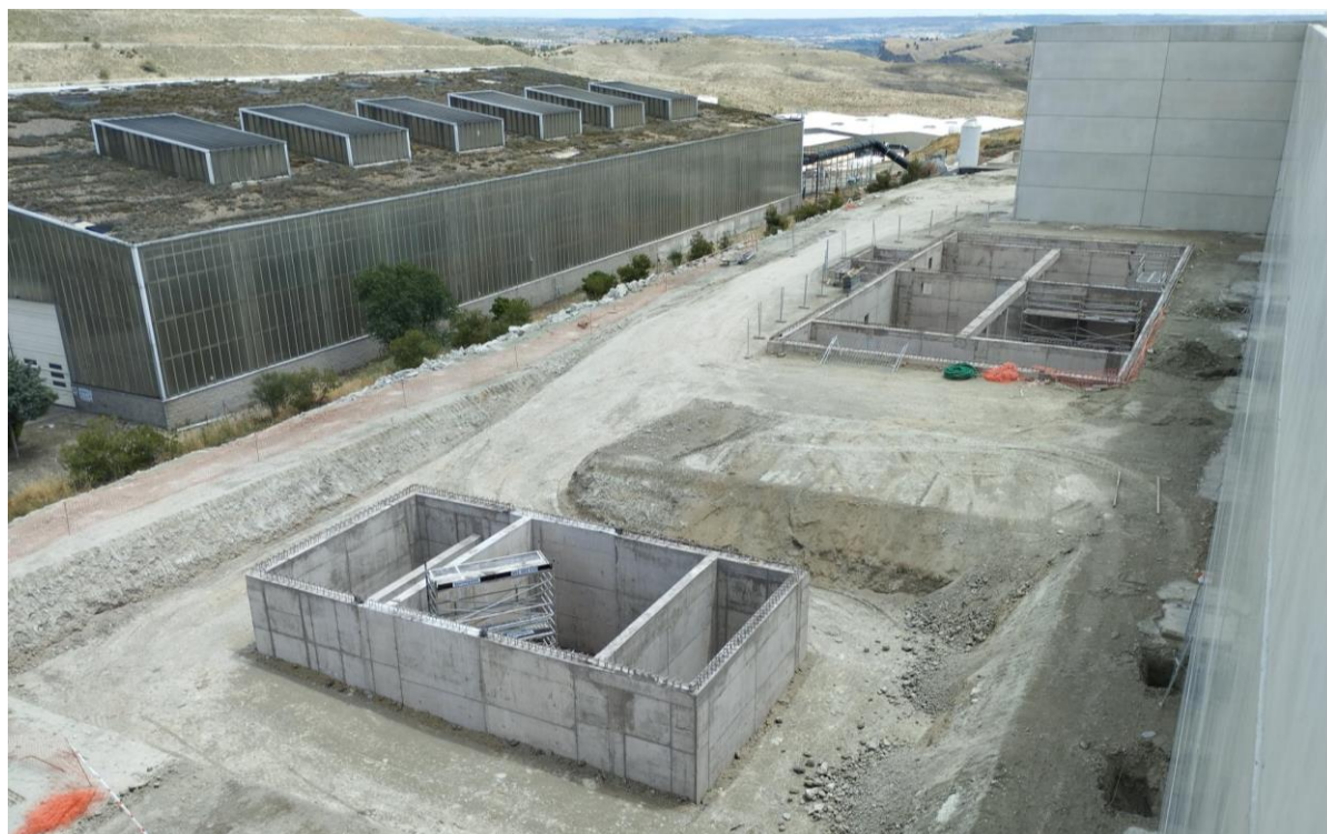
Ejecución de depósitos enterrados.
