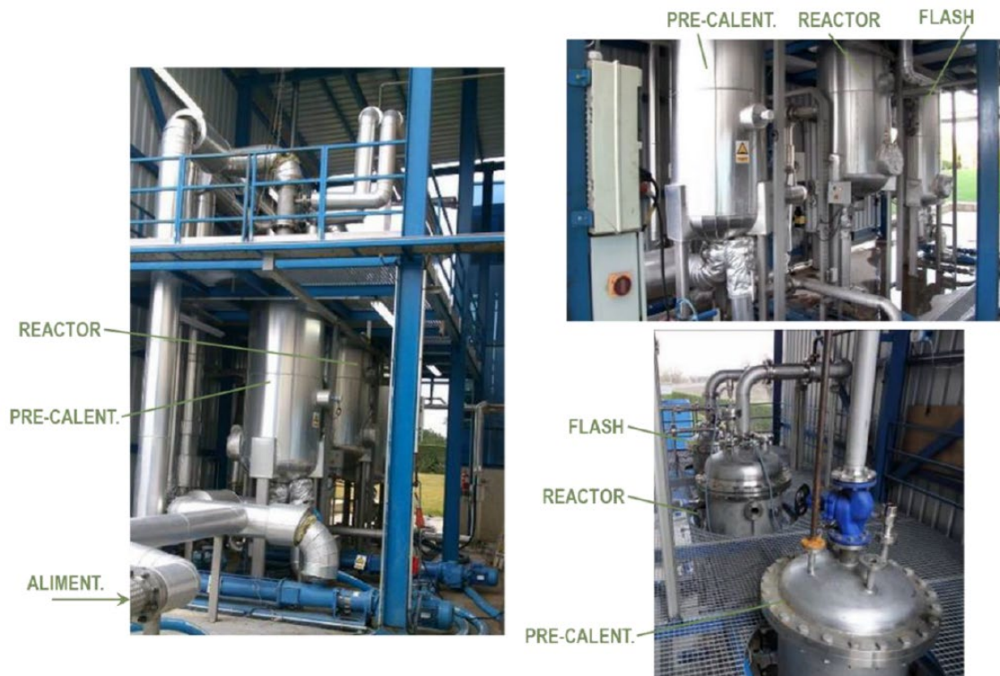
Figura 7: Vistas detalladas de la planta industrial de HT en al EDAR de Valladolid
