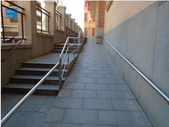
Rampa acceso al centro cultural
