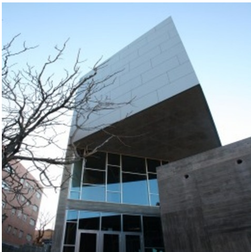
Fachada de la biblioteca
