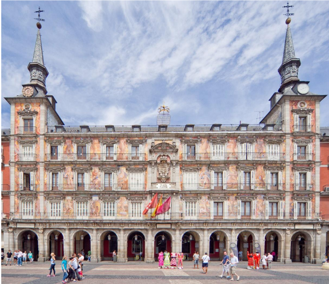
Ilustración 1. Casa de la Panadería, Plaza Mayor de Madrid. Fuente: Wikimedia Commons
