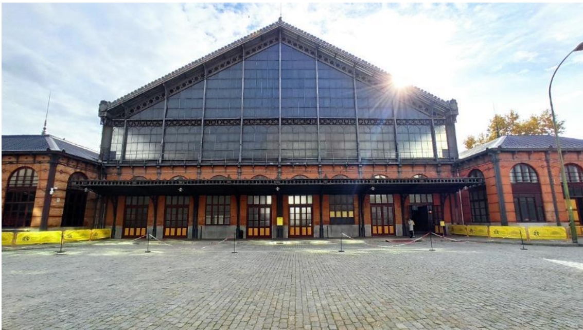
Imagen 1 Exterior de la estación
