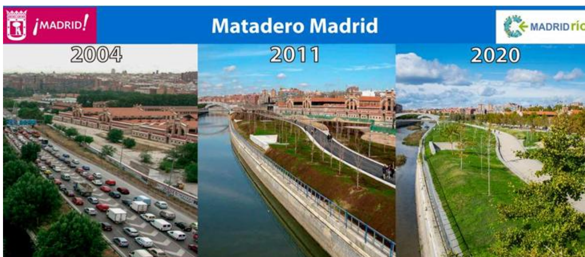
Cambios durante la construcción de Madrid Río en la zona de Matadero. Fuente: Ayuntamiento de Madrid.
