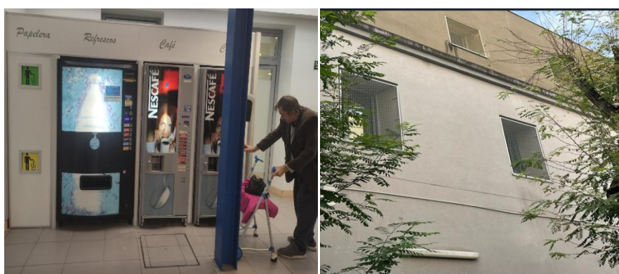
Adaptación zona vending Cerramientos ventanas
