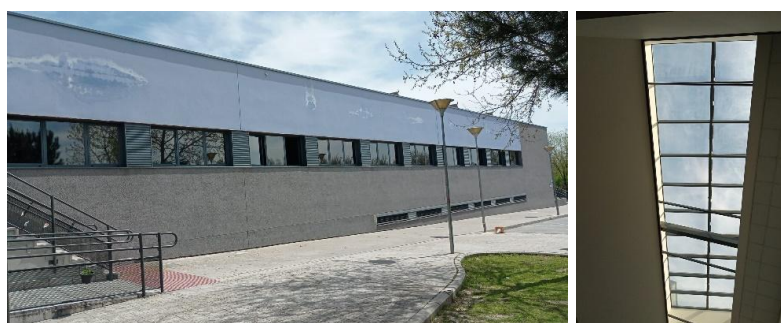
Instalación de vinilos solares en el Centro Municipal de Acogida Puerta Abierta
