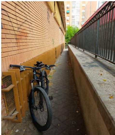
Mantenimiento de instalaciones entorno a la Pensión Longares
