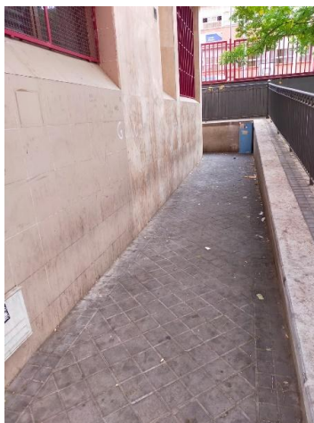
Mantenimiento de instalaciones en torno a la Pensión Longares
