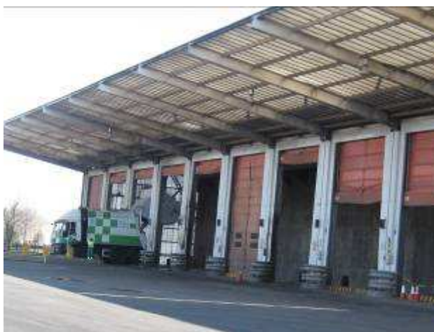
Foto 7. Pórtico previsto para vertido en foso de vehículos tipo ampliroll
