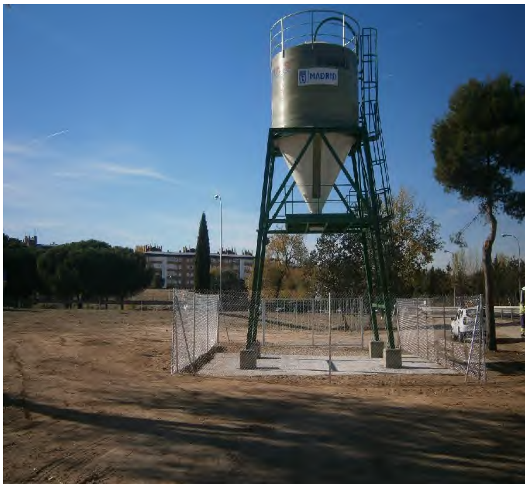
Foto. 4 Fotografía de silo de sal de 35 tm en A-5
