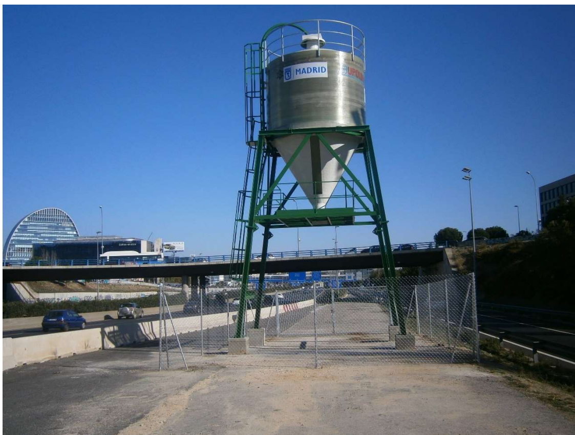
Fot. 2 Fotografía de silo de sal de 35 tm en A-1
