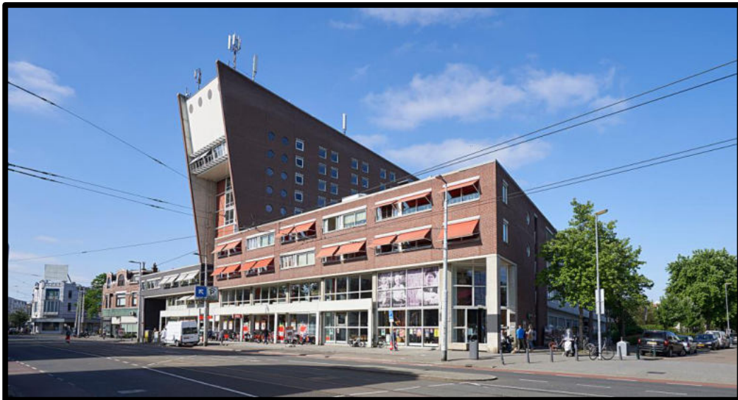
Ilustración 23 - Humanitas Bergweg, Rotterdam
