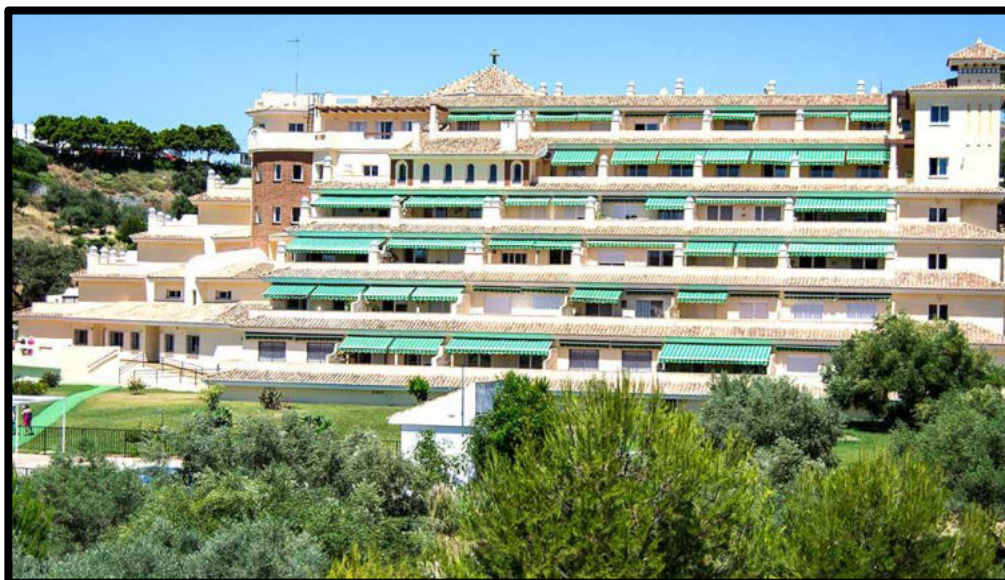
Ilustración 17 - Instalaciones del Residencial Santa Clara 20
