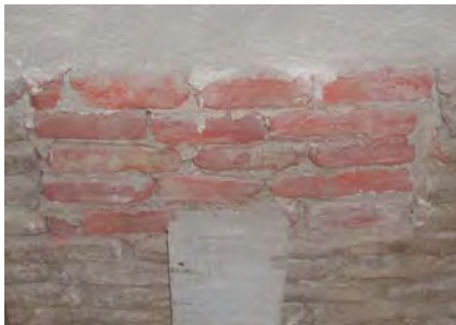
25. Cegamiento del apoyo del eje horizontal
