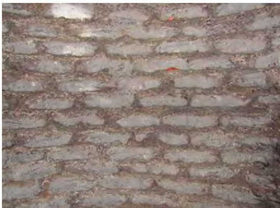
21. Detalle de la fábrica
