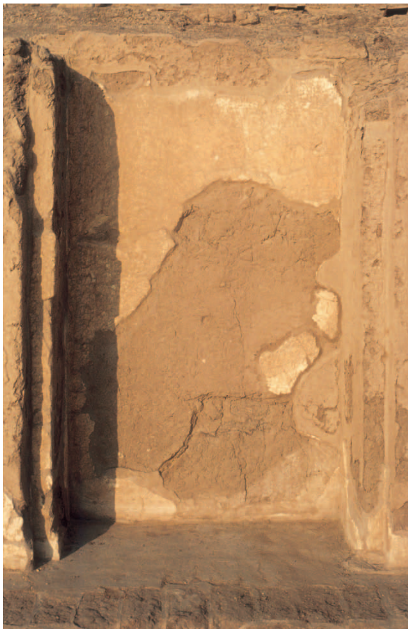
El mismo sector del muro este después de los trabajos de restauración-conservación. (Foto: Luis Manuel González)
