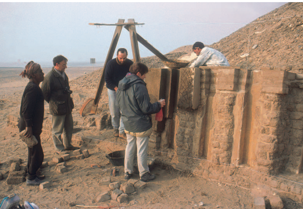
Restitución de un tramo de muro cerca del ángulo sudeste de la mastaba 16.
