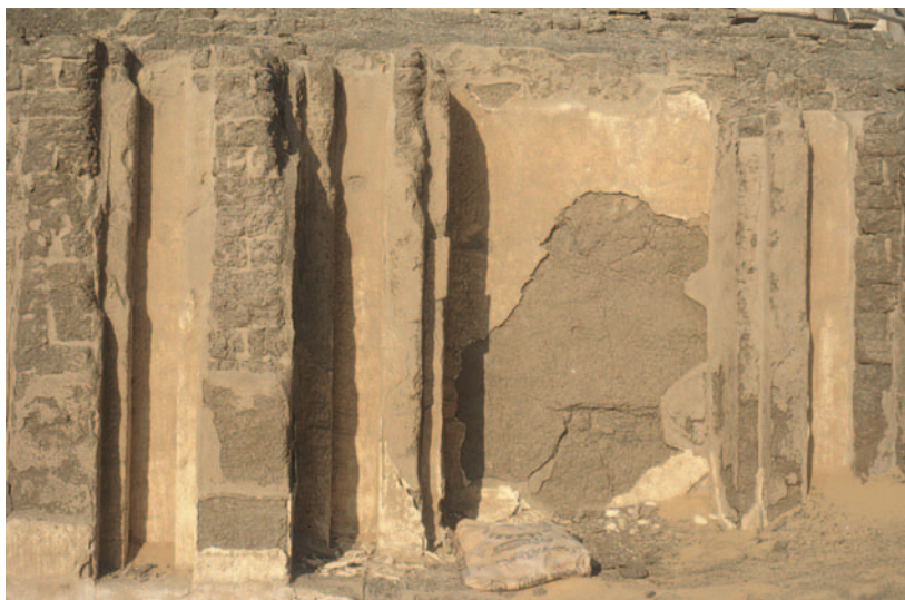
Un sector del muro este antes de los trabajos de restauración-conservación. (Foto: Luis Manuel González)
