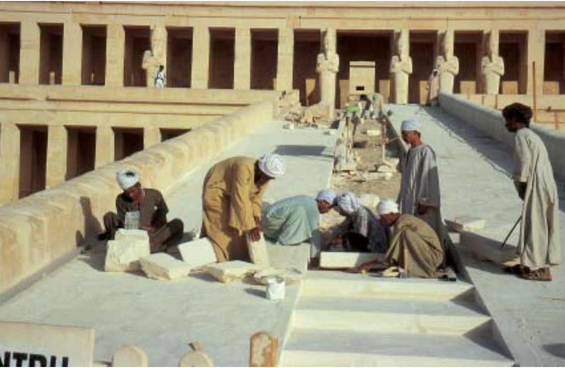
Travaux de reconstruction de la rampe d'accès à la terrasse supérieure. (Cliché © M. El-Bialy)
