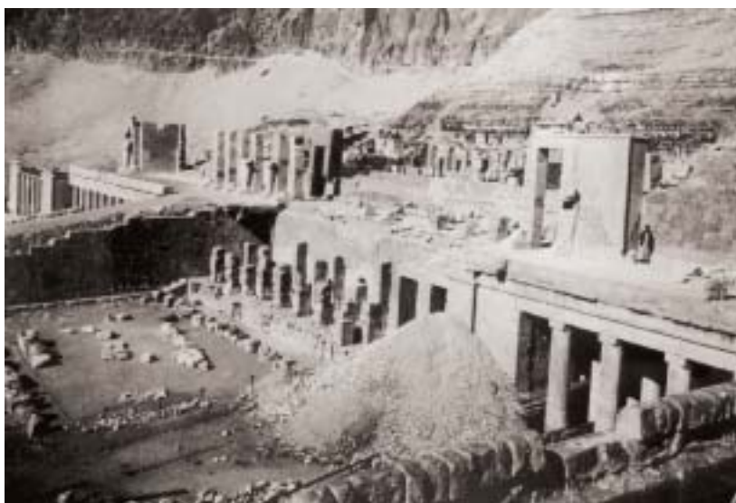
Le temple de la reine, avant les travaux de restauration, vers 1950. (Cliché © M. El-Bialy)
