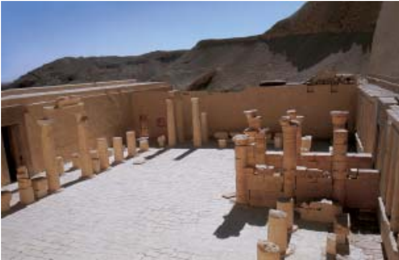
La terrasse supérieure après sa restauration. (Cliché © M. El-Bialy)
