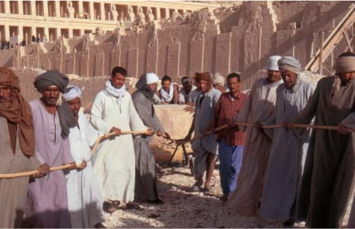
Travaux de restauration. Transport des blocs de pierre à l'usage traditionnel.
