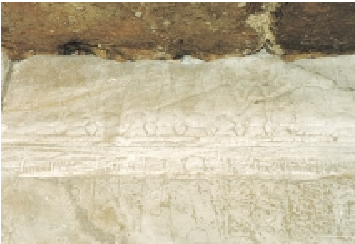
Capilla de Adijalamani. Eflorescencias salinas sobre los relieves
