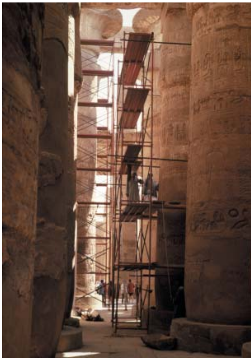
Restauration des colonnes de la Salle Hypostyle. (© CNRS-CFEETH)
