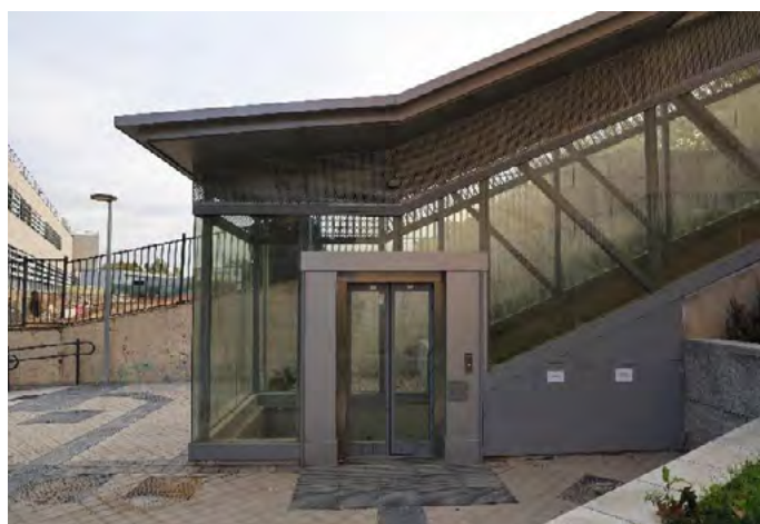
Ascensor urbano en calle Sepúlveda
