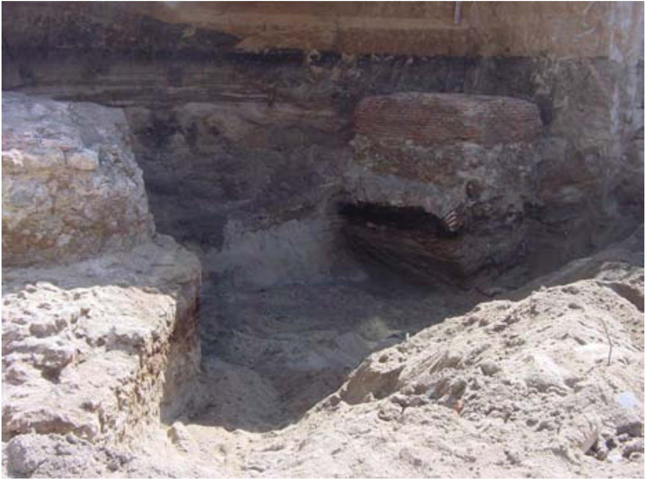
Vista general de las pilas 1 y 2 desde el Noroeste.
