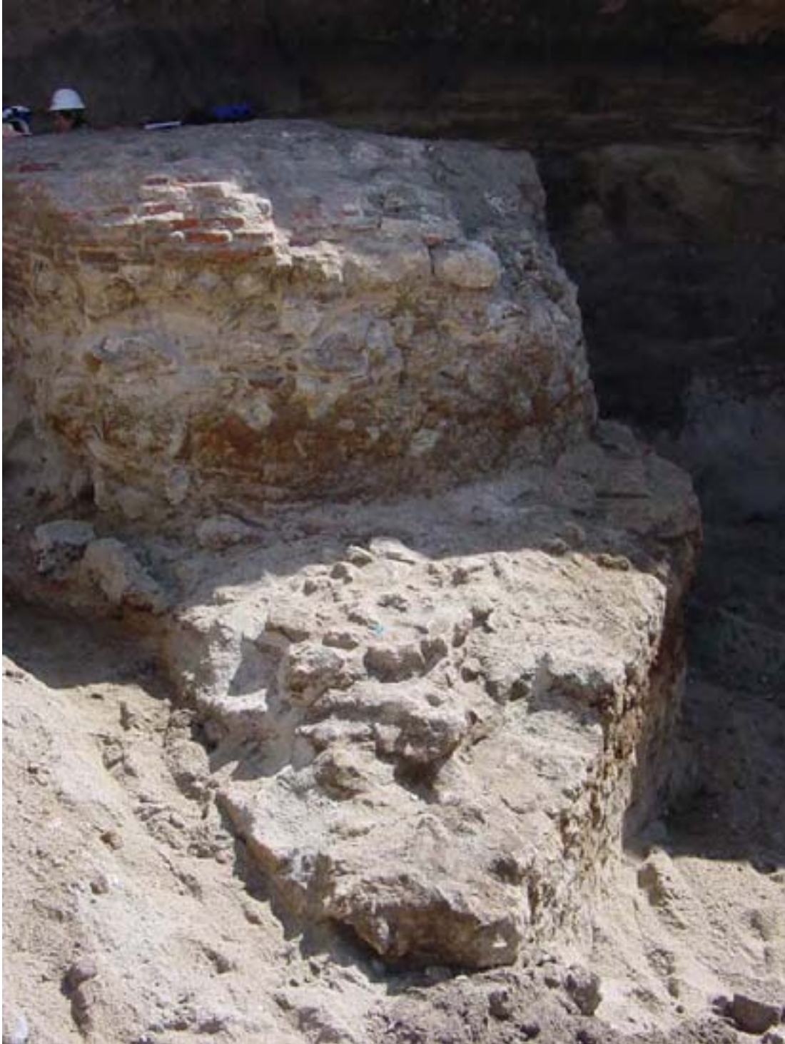
Pila 1, detalle de su tajamar aguas arriba.
