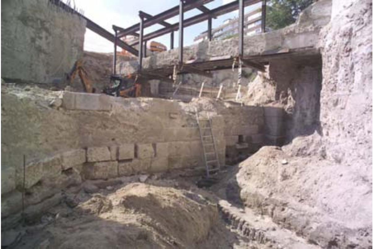
Vista de la Cabecera completa en el Ramal 11.
