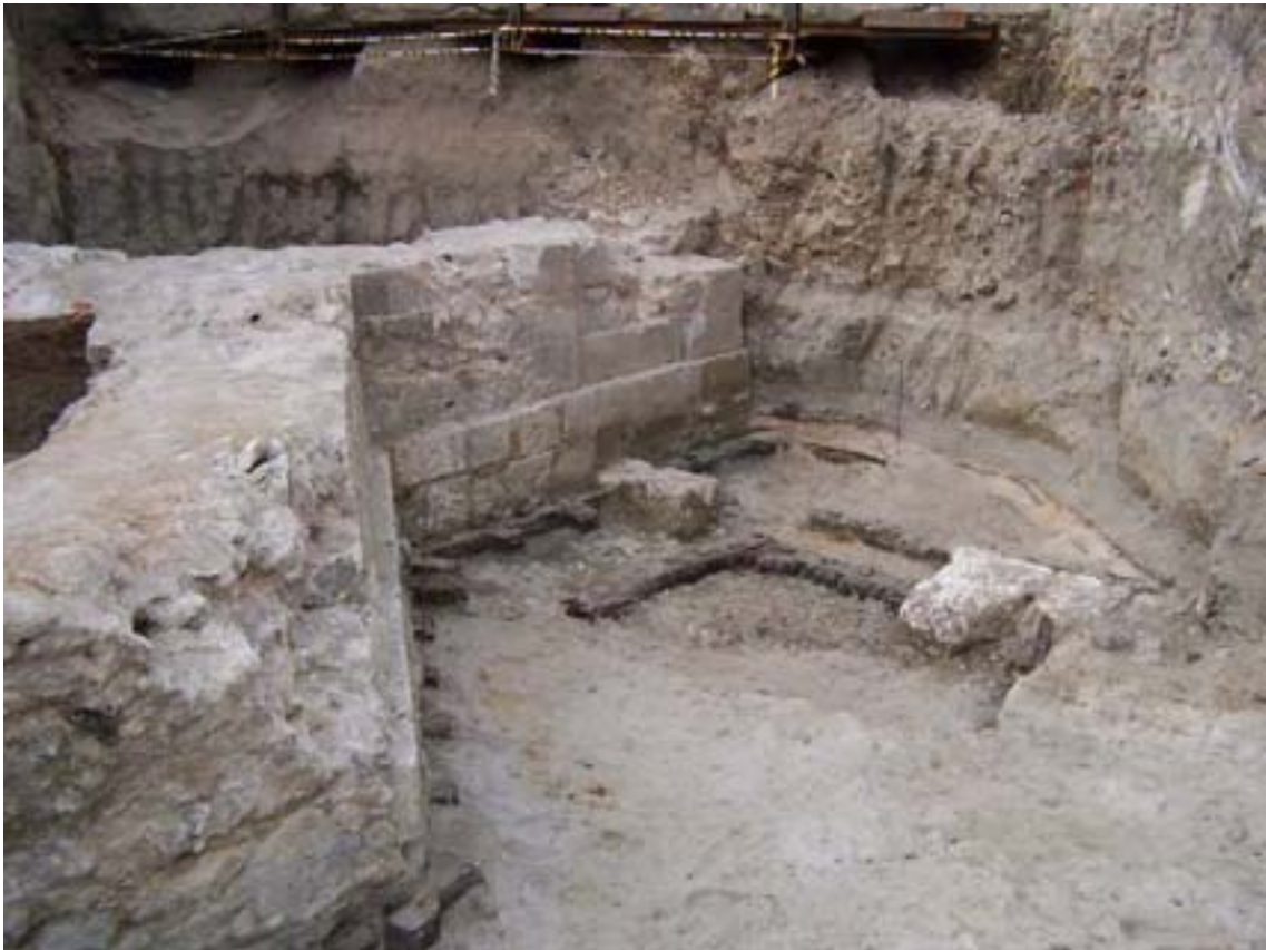
Cabecera y trazado del Canal. Sistema de carpintería para cimentación al Sur del prisma de alta tensión
