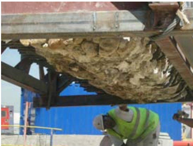
12. Extracción del Arco Este (P1. AE1) con grúa de 100 toneladas, carga y traslado a almacén. El arco extraído tiene un peso de 14 toneladas.
