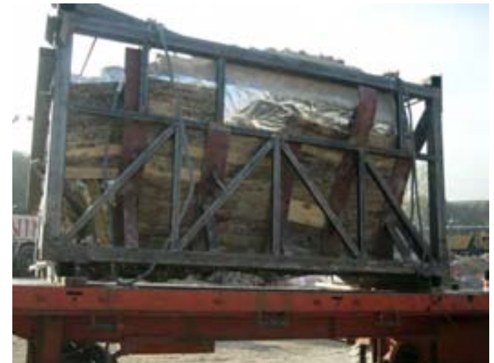
13. Extracción y carga para traslado del Arco Oeste (P1. AO1). La forma y la base del arco eran más irregulares que la del arco Este por lo que los refuerzos estructurales se debieron adecuar a lo existente. El arco Oeste pesa 13 toneladas.
