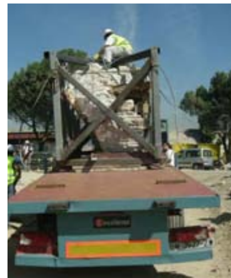
12. Extracción del Arco Este (P1. AE1) con grúa de 100 toneladas, carga y traslado a almacén. El arco extraído tiene un peso de 14 toneladas.
