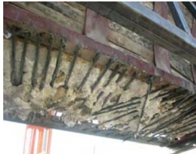
13. Extracción y carga para traslado del Arco Oeste (P1. AO1). La forma y la base del arco eran más irregulares que la del arco Este por lo que los refuerzos estructurales se debieron adecuar a lo existente. El arco Oeste pesa 13 toneladas.
