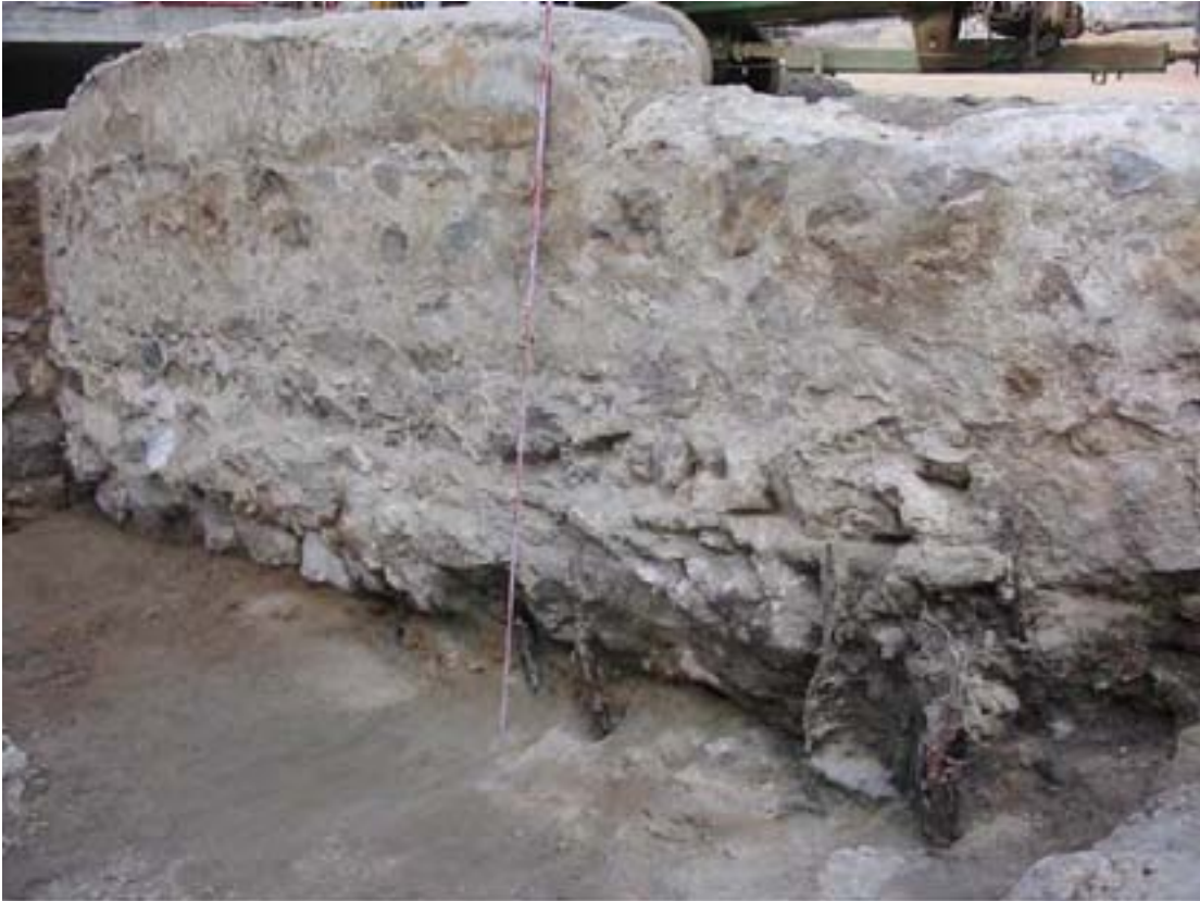
Muro acompañamiento norte
