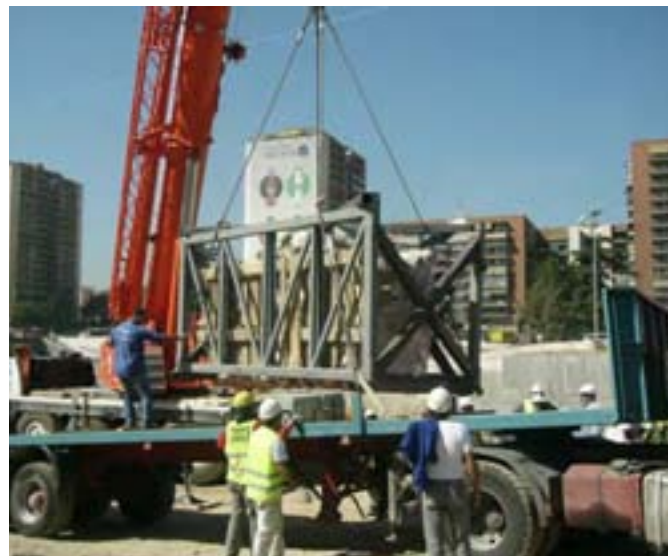
12. Extracción del Arco Este (P1. AE1) con grúa de 100 toneladas, carga y traslado a almacén. El arco extraído tiene un peso de 14 toneladas.
