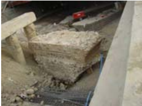
VISTA DE LA CARA SUR
