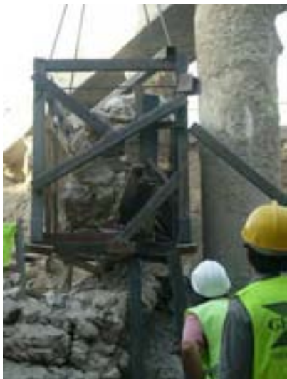
13. Extracción y carga para traslado del Arco Oeste (P1. AO1). La forma y la base del arco eran más irregulares que la del arco Este por lo que los refuerzos estructurales se debieron adecuar a lo existente. El arco Oeste pesa 13 toneladas.
