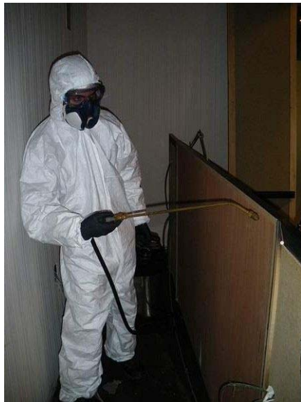
Tratamiento insecticida (pulverización residual) de las superficies interiores del cabecero y paramentos. (Fotografías Rentokil-España.)
