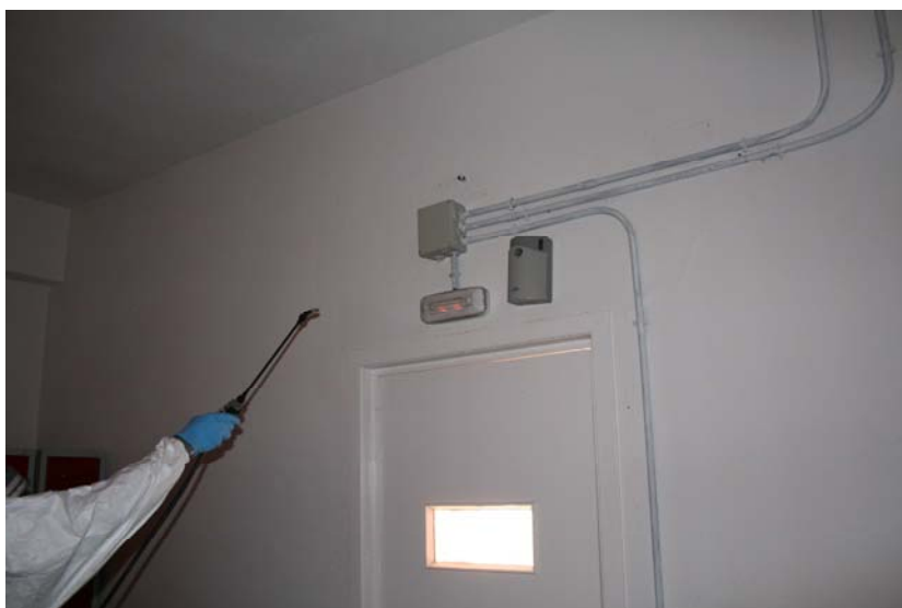
Tratamiento de pasatubos y elementos eléctricos; Puede ser necesaria la desconexión eléctrica previa; En este tipo de materiales, puede ser preferible evitar líquidos seleccionando el empleo de formulaciones en polvo. En todo caso, es necesario evaluar el riesgo laboral así como el posible daño a la instalación. Análogas consideraciones son necesarias respecto a material electrónico delicado (TVs, relojes-despertadores, ordenadores, etc...). (Fotografía UTCV-Madrid Salud)
