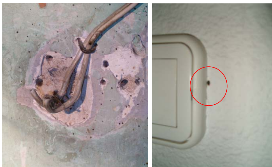
Chinchas; Pasa-tubo eléctrico en dormitorio infestado; estos pasatubos sirven con frecuencia como vía de diseminación del parásito de una habitación/vivienda a la próxima, especialmente en situaciones de aplicación insecticida incorrecta (aerosoles/termonebulizaciones). (Fotografías UTCV-Madrid Salud)
