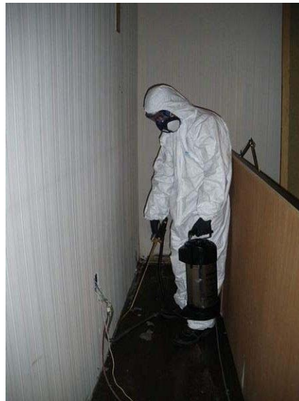
Tratamiento insecticida (pulverización residual) de las superficies interiores del cabecero y paramentos. (Fotografías Rentokil-España.)
