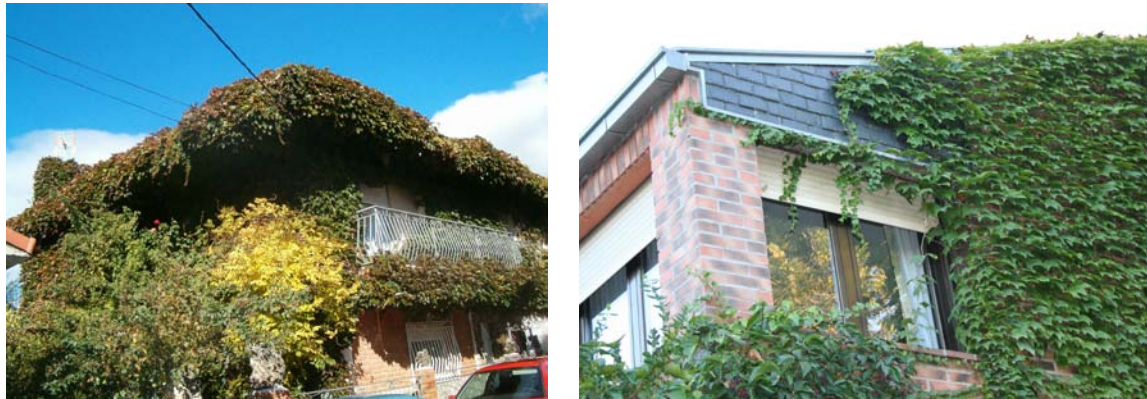
VEGETACIÓN: excesivo crecimiento que favorece refugio, alimentación y accesos de artrópodos a viviendas (Fotografías UTCV-Salud Ambiental)
