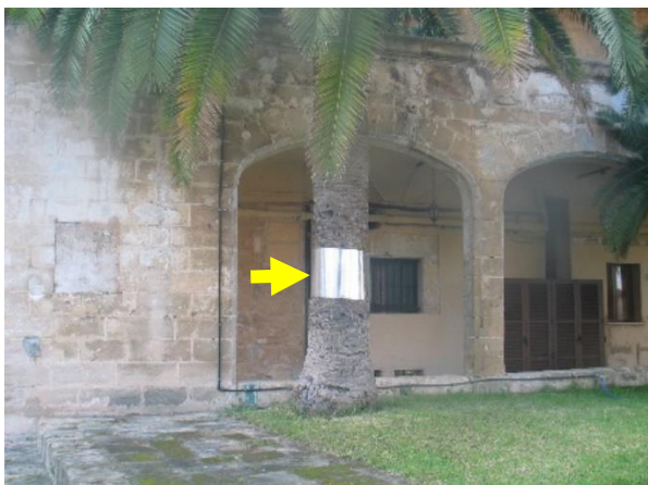
Ejemplo de instalación de barrera (anillado) en árbol.
