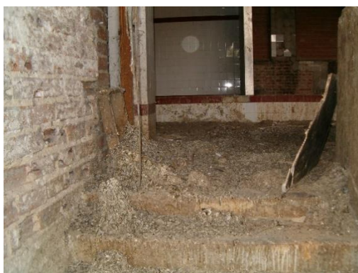
Ejemplo de depósitos de excrementos y otros residuos en inmueble abandonado y transformado en palomar (Fotografías: DCV)
