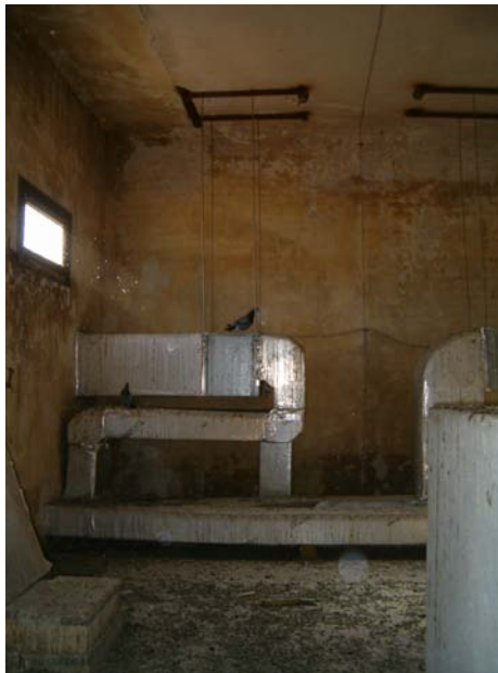
Depósitos de excrementos en espacio bajo cubierta con instalaciones de climatización-HVAC. Se trata de unos de los escenarios de mayor riesgo (aerosoles contaminados).
