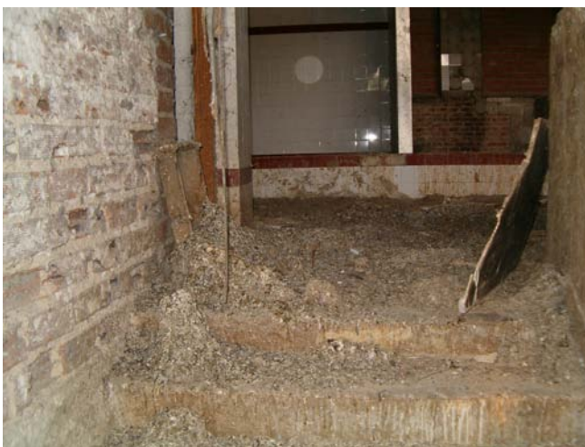
Depósitos de excrementos /otros residuos en inmueble abandonado y transformado en palomar
