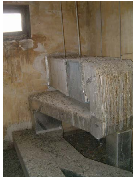
Depósitos de excrementos en espacio bajo cubierta con instalaciones de climatización-HVAC. Se trata de unos de los escenarios de mayor riesgo (aerosoles contaminados).
