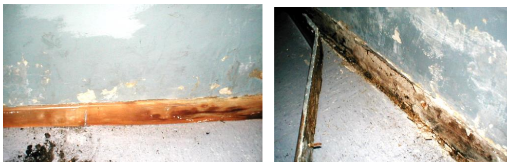
Humedad afectando a pared y rodapié. Este muestra importante infestación de termitas (Fotografías DCV-Madrid Salud)
