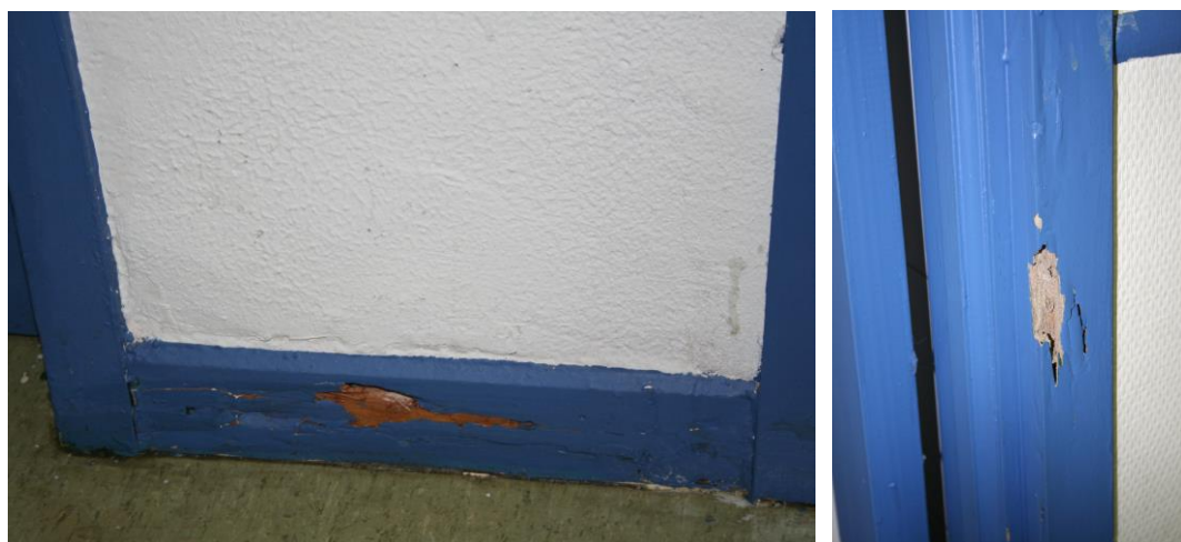
Daños en carpintería. La madera aparece con aspecto arrugado debido al deslaminado. Resulta friable y, en infestaciones activas, es posible ver actividad de los insectos (Fotografías DCV)
