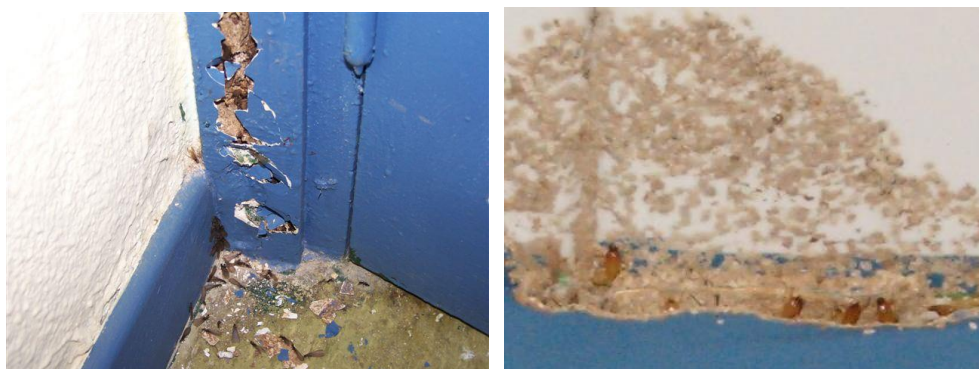
Humedad afectando a pared y rodapié. Este muestra importante infestación de termitas (Fotografías DCV-Madrid Salud)
