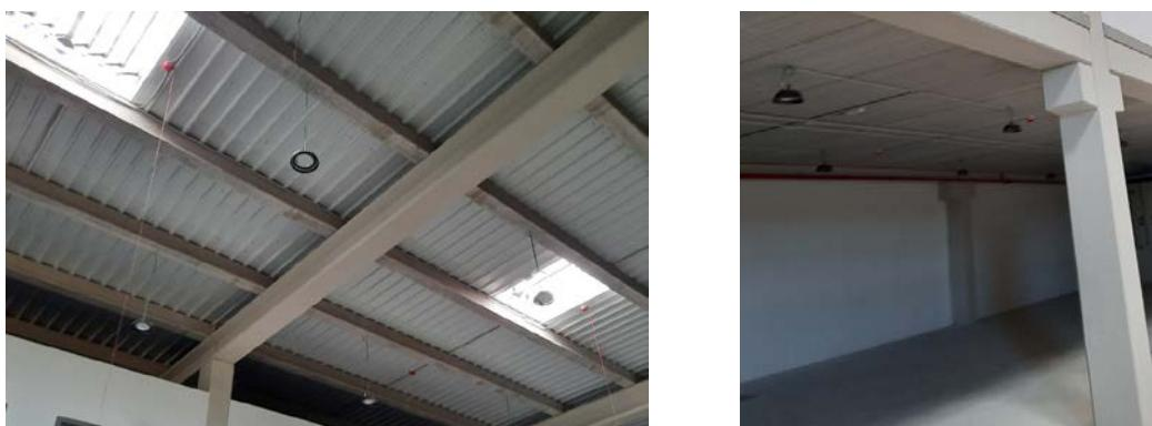
Para alumbrado de emergencia general se montarán luminarias empotradas, con tecnología LED, Ø46mm, para los locales técnicos y zona de producción se proyectarán luminarias de superficie, semiempotrada, con carcasa y difusor en policarbonato, con lámpara LED. Todos los equipos de emergencia irán dotados de equipos de AUTOTEST. El alumbrado de emergencia se incluirá en dotación suficiente en todos los recorridos de evacuación y cuadros eléctricos, de acuerdo con el REBT ITC-28.
