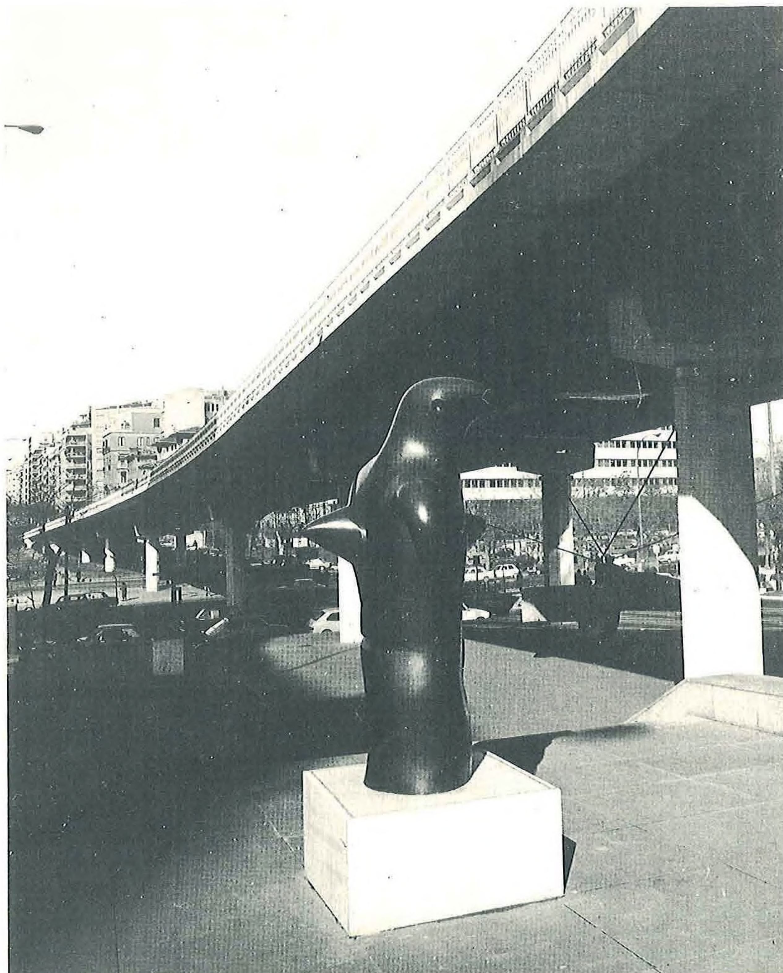
Paso elevado entre la C/. Juan Bravo y el Paseo de Eduardo Dato sobre el Paseo de la Castellana. Museo de Esculturas, 1970.
