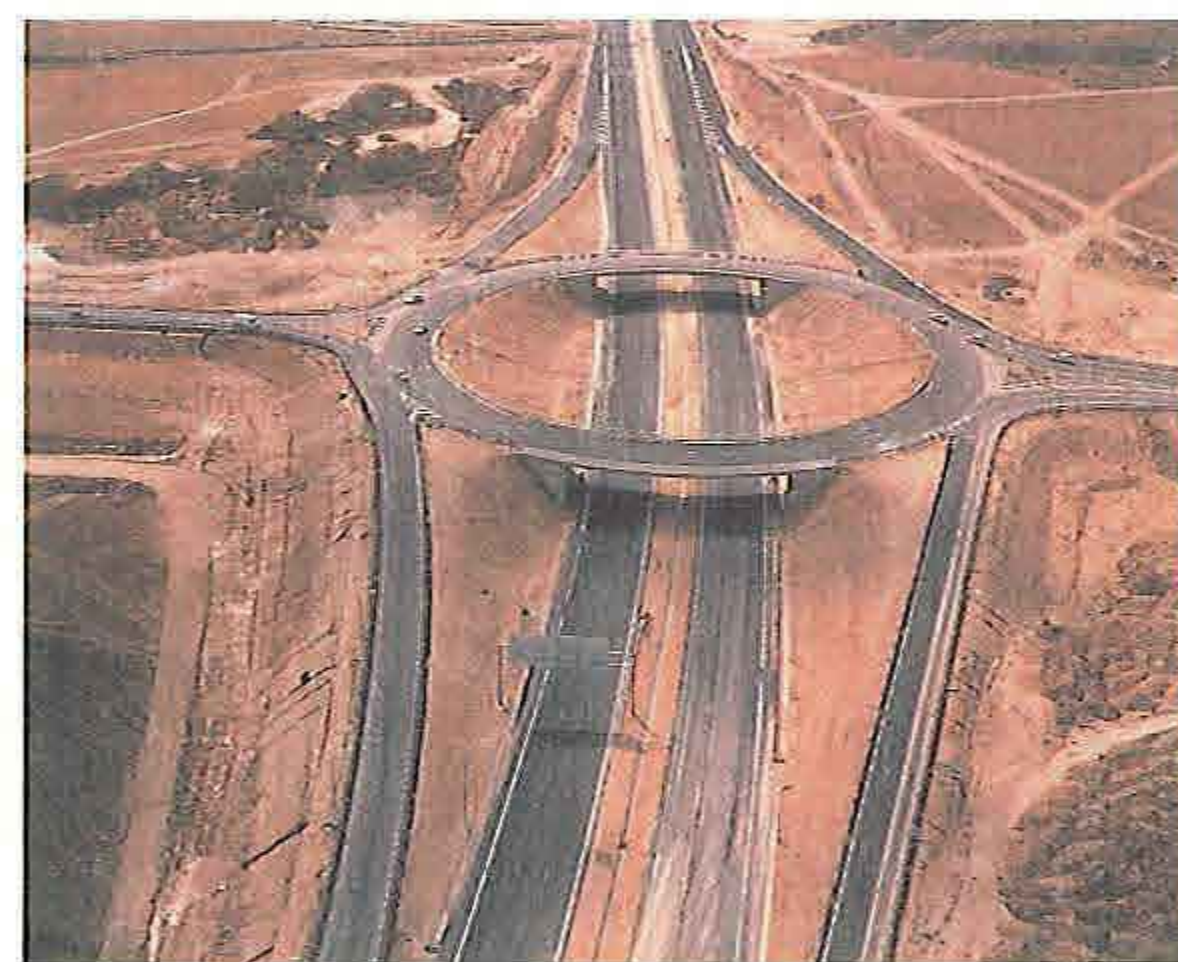
1991. Distribuidor Este. Intersección de enlace Coslada-Las Musas. Accesos a Madrid M-40. Convenio: MOPU- Comunidad de Madrid- Ayuntamiento de Madrid.
