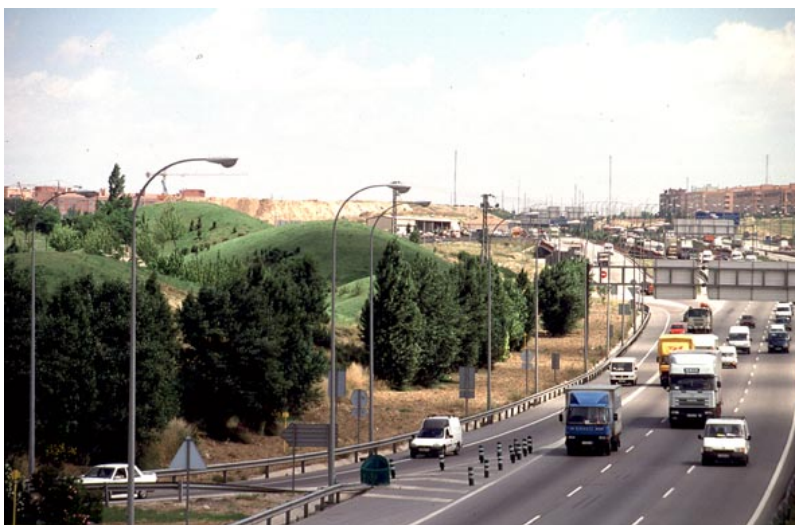
DIQUE DE TIERRA PARA AISLAMIENTO SONORO
