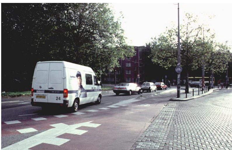
INTERSECCIÓN CICLISTA CON PAVIMENTO TRATADO
